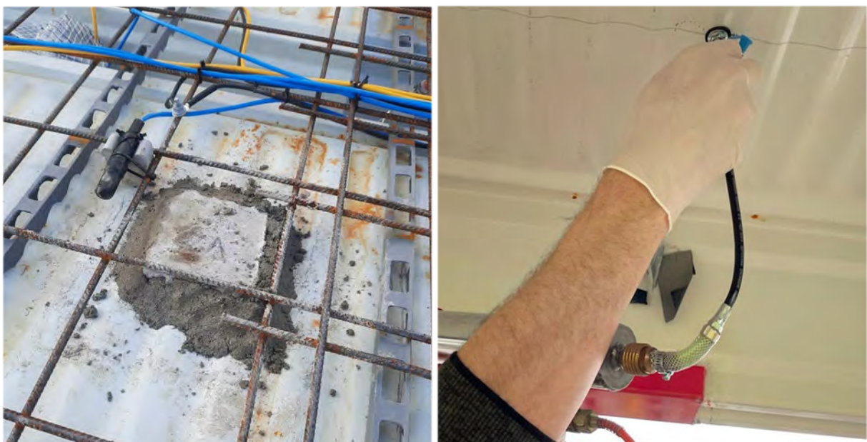
Abbildung 100: Pilotprojekt Kissing - Hohlstelle vor Betonage (links) und Einpressen des Gels (rechts)
