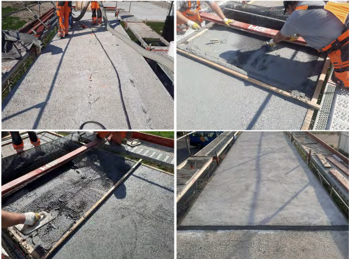
Abbildung 98: Pilotprojekt Kissing - Fotodokumentation der Instandsetzung der Deckenoberseite
