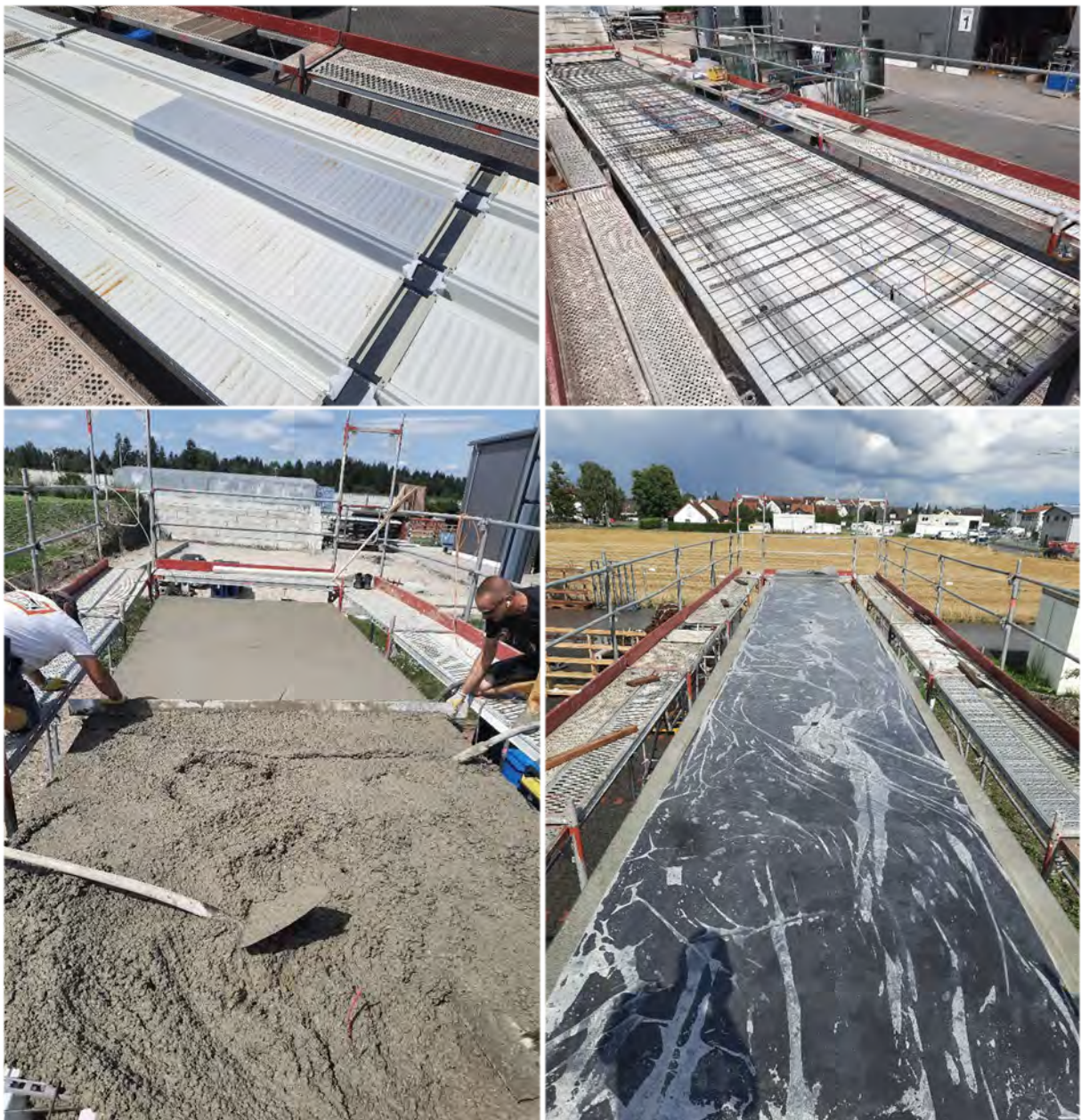
Abbildung 93: Pilotprojekt Kissing - Fotodokumentation der Deckenbetonage
