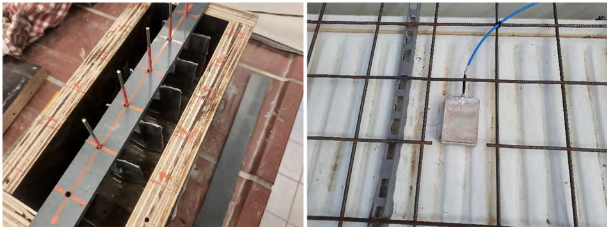
Abbildung 94: Pilotprojekt Kissing - Korrosionsproben Betonage (links) und Einbau (rechts)
