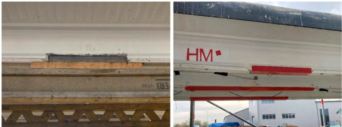
Abbildung 103: Pilotprojekt Kissing – Anpressen des Profils von unten (links) und fertige Verstärkung (rechts)
