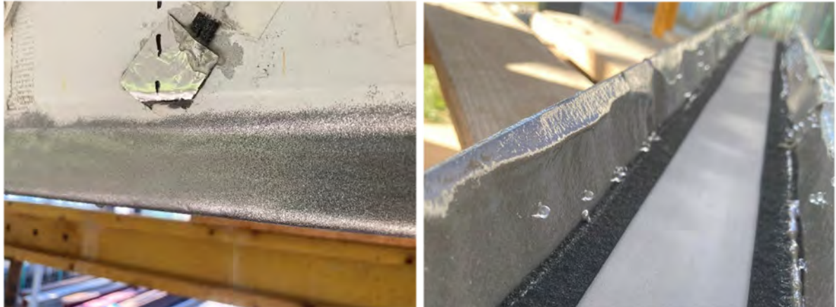
Abbildung 102: Pilotprojekt Kissing – Untergrundvorbereitung der Klebfläche an der Profiltafel (links) und Vorbereitung U-Profil Klebstoffauftrag, Glaskugeln sowie Abdichtungsband (rechts)
