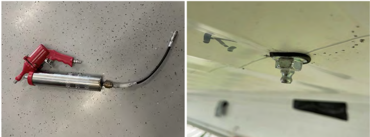
Abbildung 99: Pilotprojekt Kissing - Schmierpumpe zum Einpressen des Acrylatgels (links) und eingebrachter Injektionspacker (rechts)
