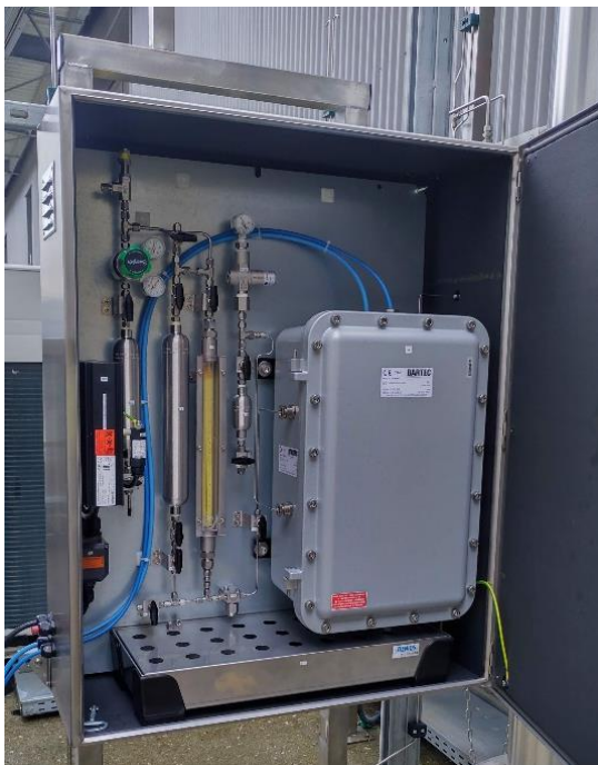
Abbildung 5: \mu - Odorierstation – Dosiereinheit und Impfstelle
