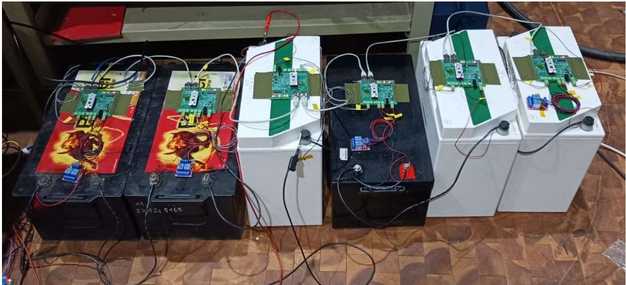
Abbildung 51: Labortestaufbau des BMS mit sechs Batterien
