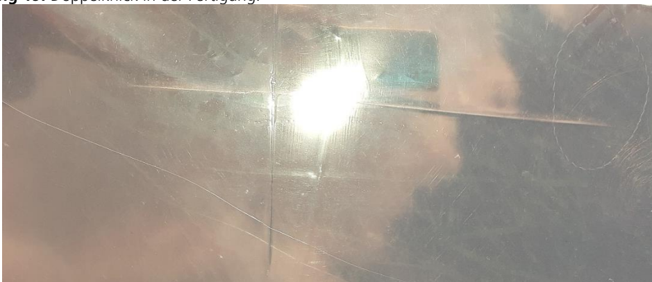
Abbildung 20: Schadstelle in eingebautem Zustand.
