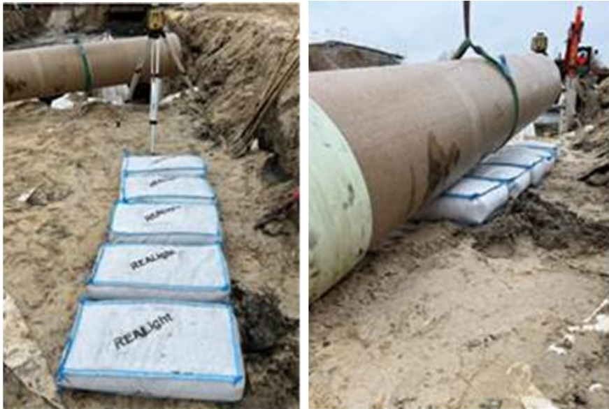
Abbildung 26: Auslegen (li.) der Matratzen in Verlegerichtung und Verlegung der Rohre (re.) (Fotos: Hansegrand Klimabaustoffe e.K.)
