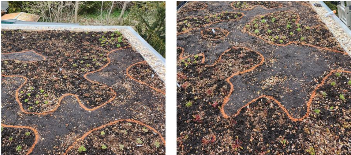
Abbildung 25: Versuchsfläche von Substrat mit Leichtgranulaten für Carport für Winterdienstfahrzeuge auf dem TBR Betriebshof (Foto: T.B.R.)
