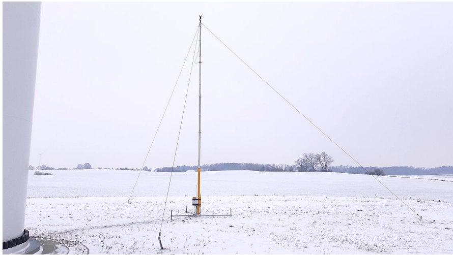
Abbildung 17: Ultraschall-Anemometer auf dem 10-Meter-Mast, neben der Referenzanlage
