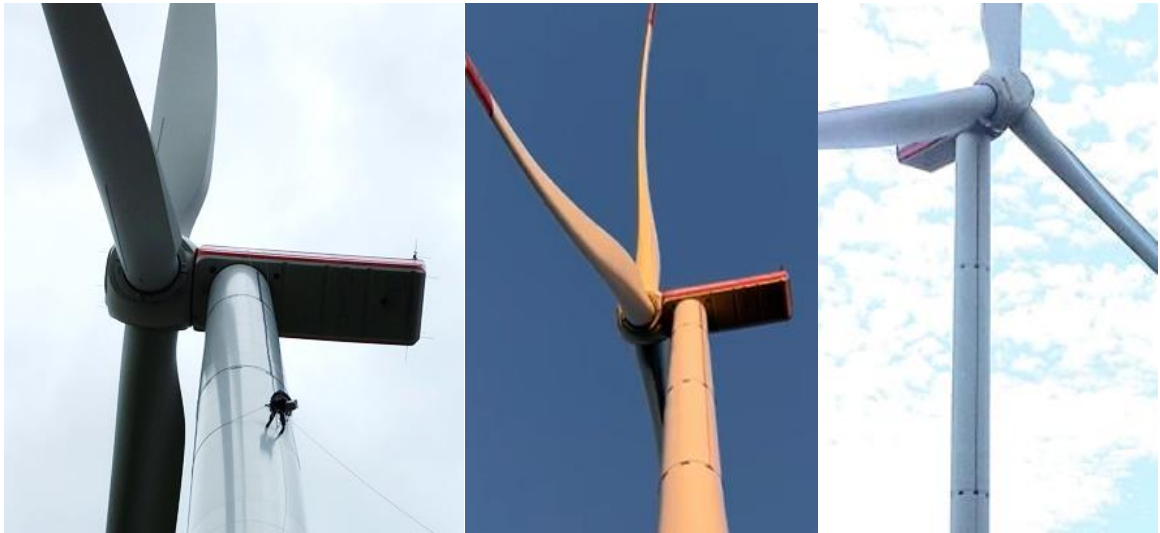
Abbildung 15: Installation der Druckmessstellen auf dem Turm (links) und Übersicht der Druckmessstellen auf dem Turm (Mitte und rechts).
