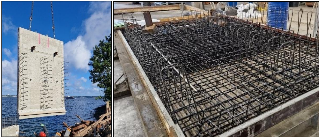
Abbildung 10: Einheben des Fertigteils auf der Baustelle (links) BFVK-Bewehrungskorb im Fertigteilwerk (rechts)
