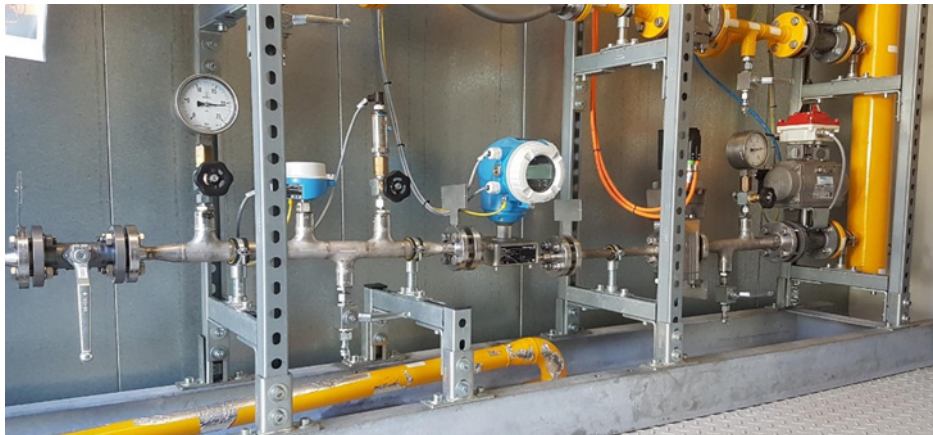
Abbildung 56: Wasserstoffpfad innerhalb der Gasmischstrecke
