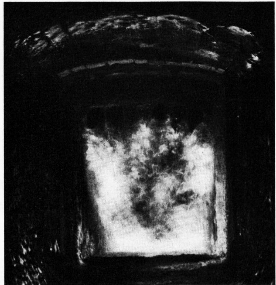
Bild 11. Blick durch den beaufschlagten Brenner bei Primärluft-Zusatz.
