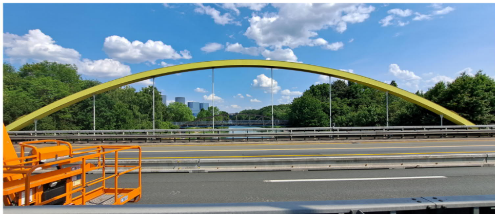
Wölfel - Abb. 8: Stahl-Bogenbrücke Datteln-Hamm, Blick auf den äußeren Bogen.
