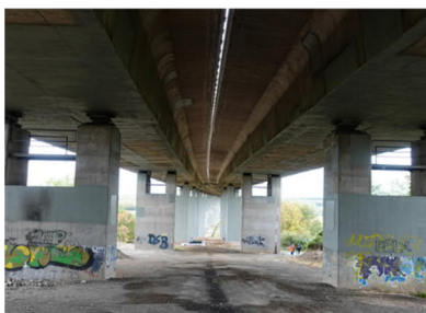
Cluster 1 – Spannbetonbrücken, Koppelfugen
