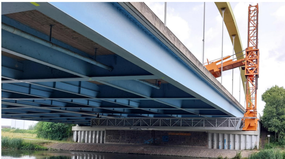
Wölfel - Abb. 11: Einsatz von Sondergerät zur Brückeninspektion und für die Instrumentierung
