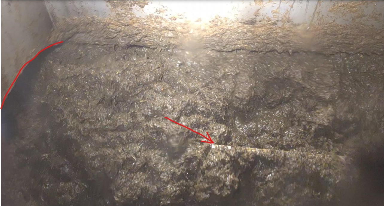
Abbildung 84: Blick durch Schauglas in Gasdom des Fermenters, links: die Wölbung des liegenden Zylinders, Pfeil markiert kurz auftauchendes Paddel vom Rührwerk
