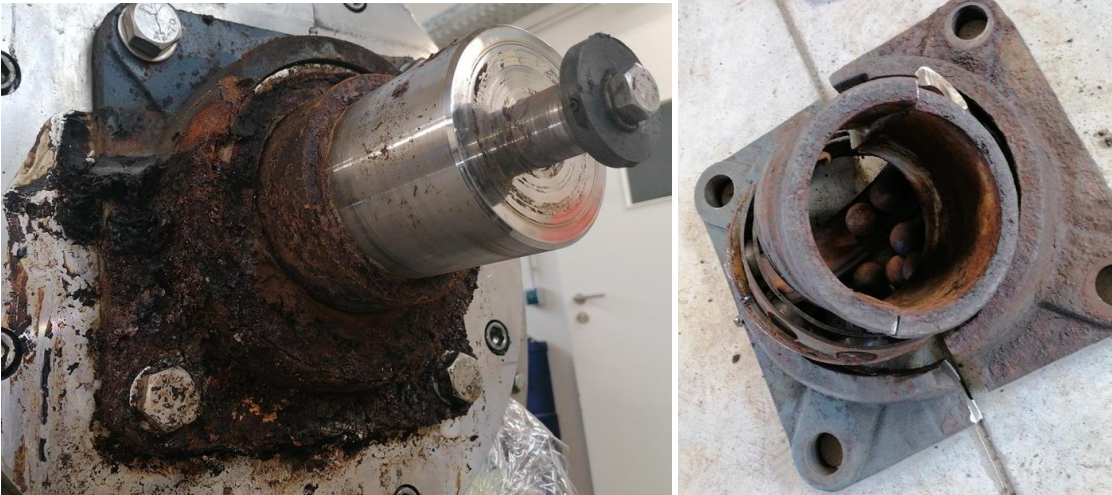
Abbildung 72: Starker Verschleiß am Wellenlager
