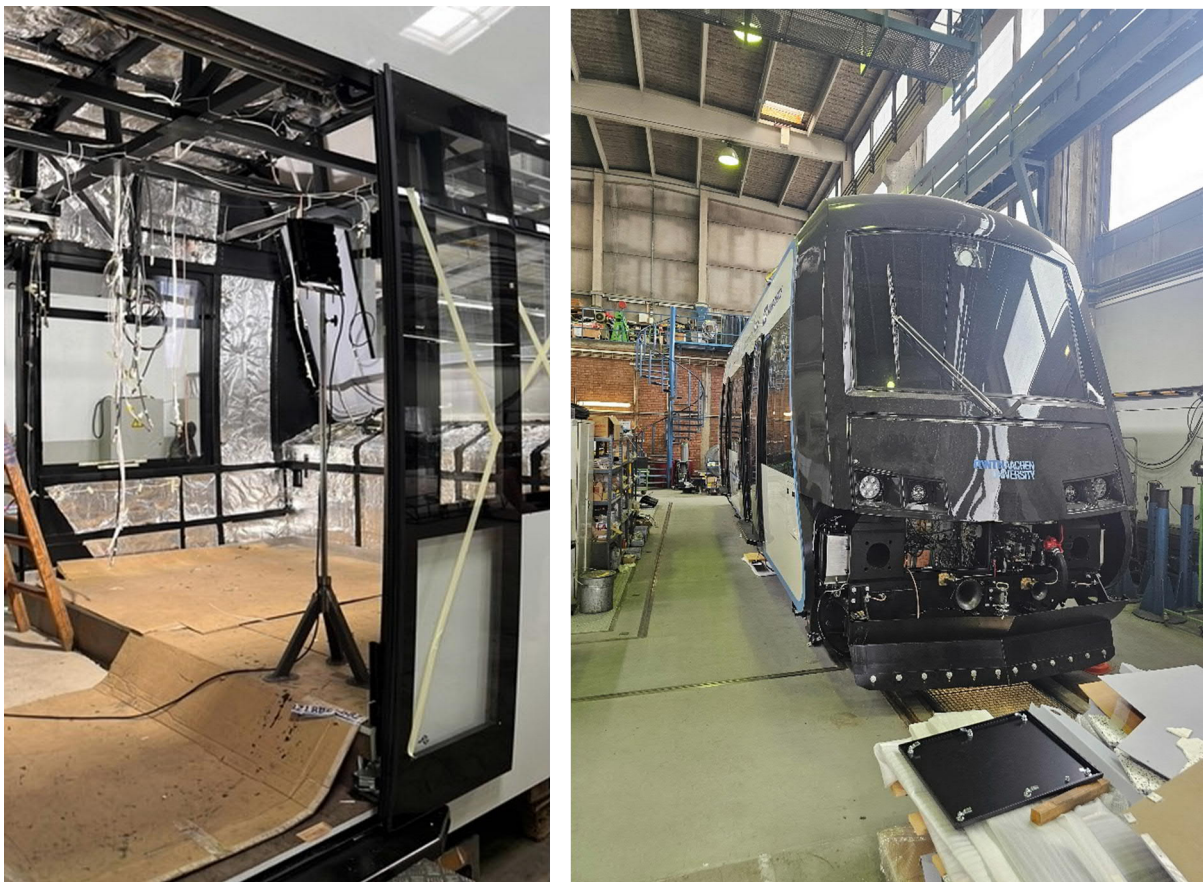
Abbildung 17: Innenausbau und Fertigstellung am ISF
