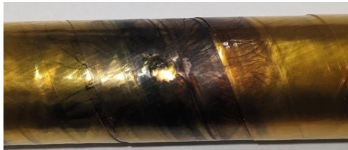
Abb. 5.6: Durchschlagskanal durch die Isolierung. Es zeigt sich eine intensive Verfärbung und Tracking ausgehend von der eingebrachten Fehlstelle
