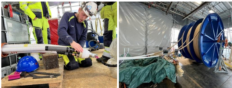
Abb. 6.20: Links: Zugkopfmontage an drei Phasen, Rechts: 3-Kammertrommel während des Kabeleinzugs
