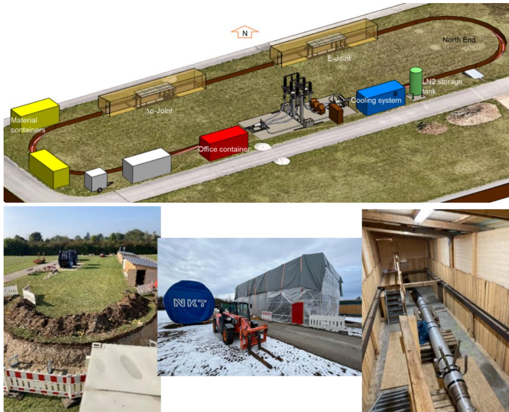
Abb. 6.18: Oben: Schematische Darstellung des Testaufbaus, Links: Erdaushubarbeiten für Kryostat-Legung Mitte: Zelt für Endverschlussmontage, Rechts: Muffengrube mit DP-Joint
