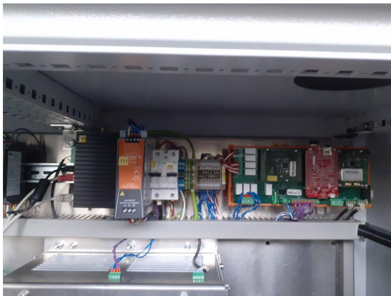
Abbildung 2-21: Ladeprozesssteuerung mit Systemüberwachung und Schnittstelle zur Fahrzeug-Drahtloskommunikation
