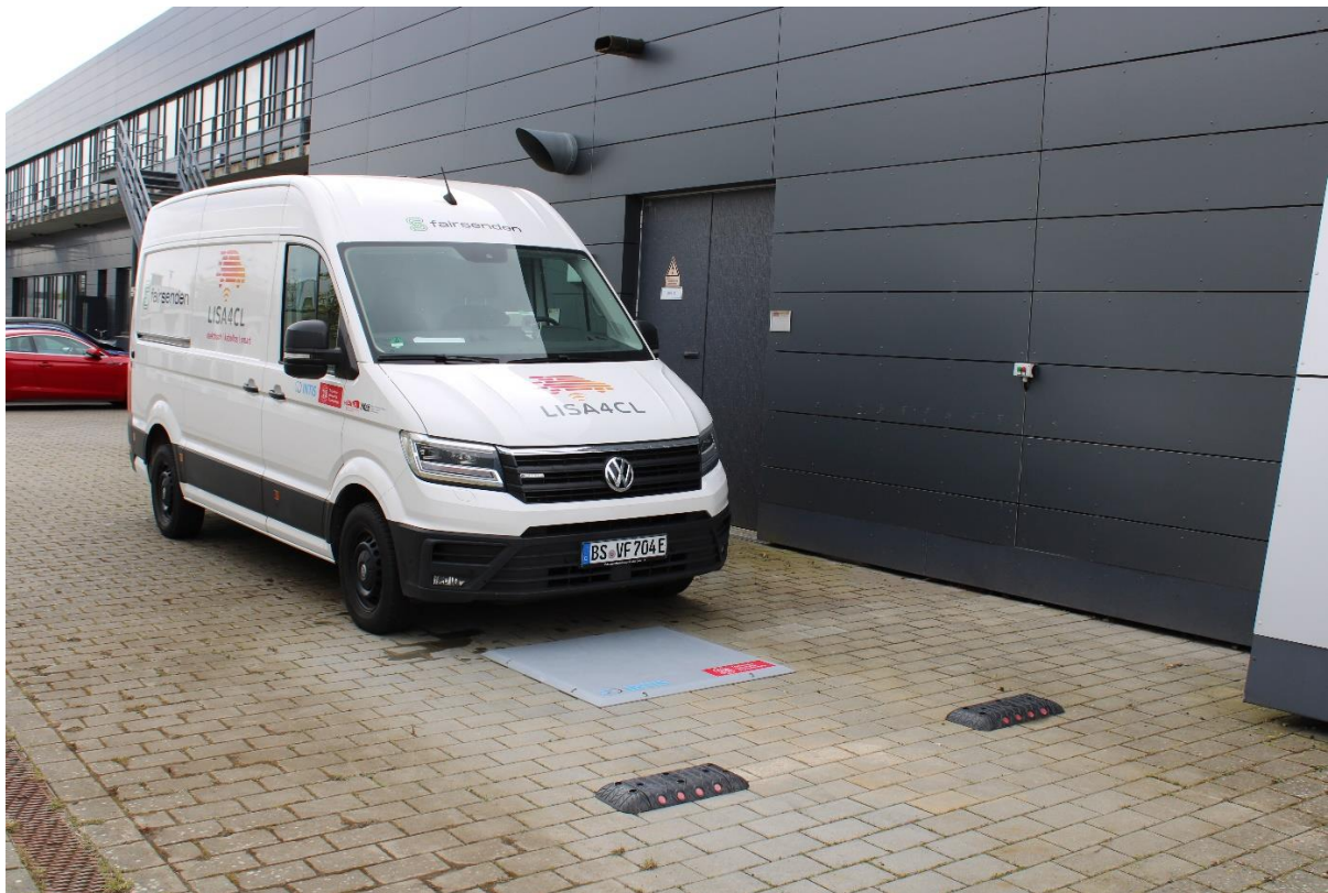
Abbildung 2-106: Einsatzbereites Ladesystem an der TU Braunschweig
