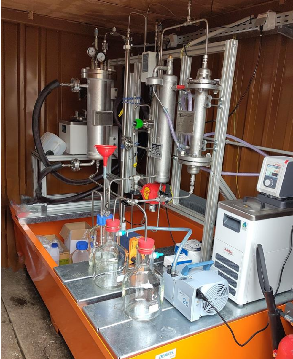
Abbildung 65: Ansicht der Bieranol-Versuchsanlage zur Absolutierung (Ausbaustufe 1)
