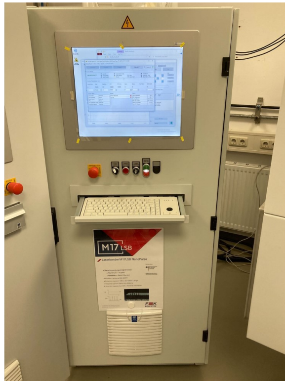
Abbildung 2 Laserschaltschrank mit Steuerungs-PC mit Lasersteuerung und Laserparametrisierung per Software.
