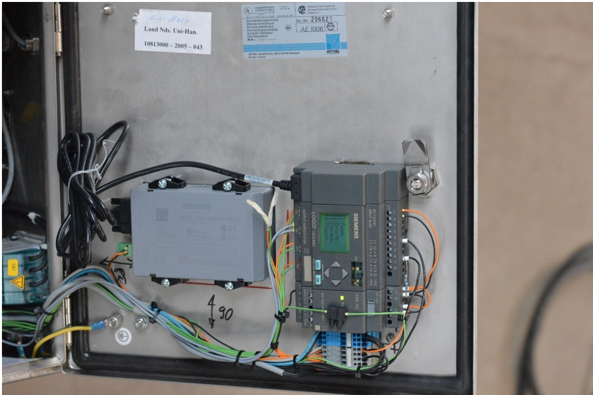
Abbildung 22: Im Schaltkasten verbaute SPS des Typs Siemens LOGO! Zur Steuerung des Ventilschaltens und Pumpen Aus- und Anlauf
