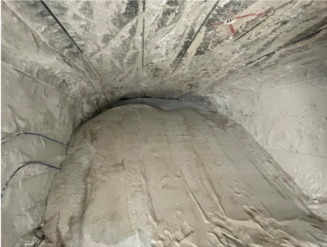
Abbildung 45: Erstböschung im KOMPASS-Bereich nach Rütteln (Foto Autor)
