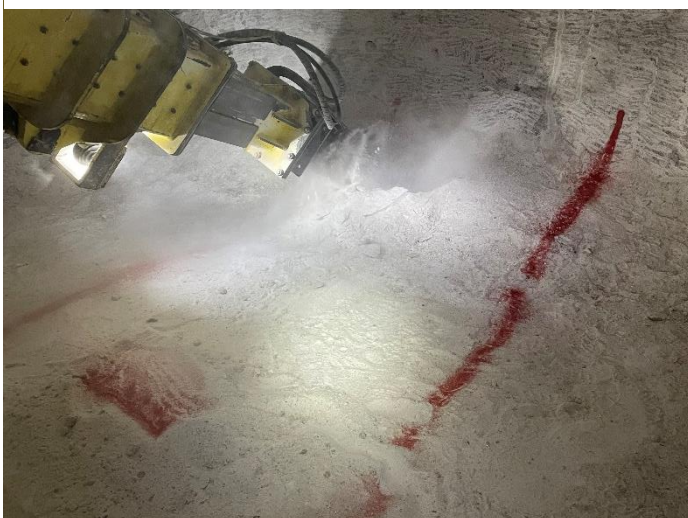
Abbildung 11. Herstellung des Grabens (Foto Autor)
