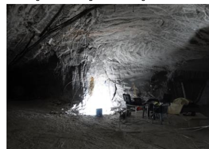
Bohrung B1: Lage der Bohrung im Pfeiler mit HF-Mess
