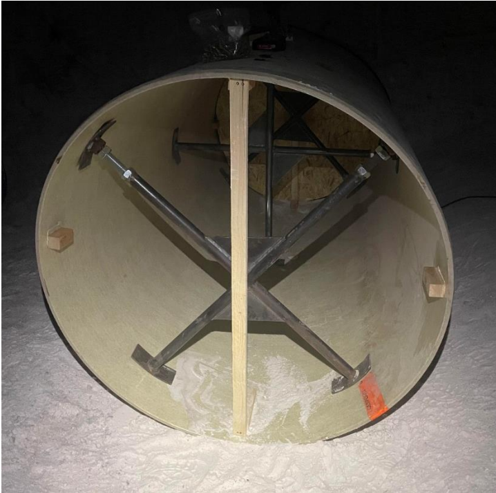
Abbildung 27: Aussteifung der Dummies mit Stahlspindeln (Foto Autor)
