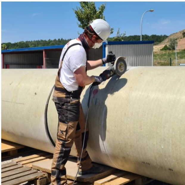
Abbildung 26: Zerlegen des GFK-Rohres in benötigte Stücke (Foto Jentzsch)
