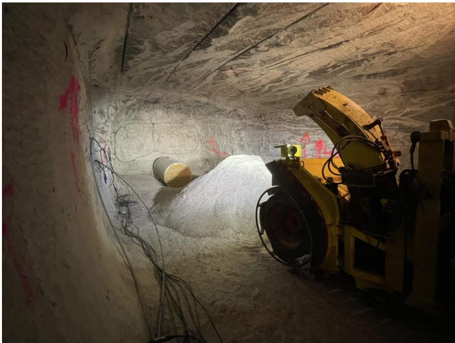
Abbildung 41: Schleuderversatzmaschine in Position vor Ortsbrust (Foto Autor)
