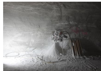
Bohrung B2: Erstellung Messbohrung
