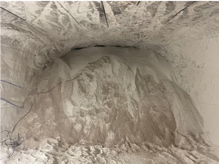
Abbildung 65: Firstbündige Verfüllung mit QSV-Material (Foto Autor)
