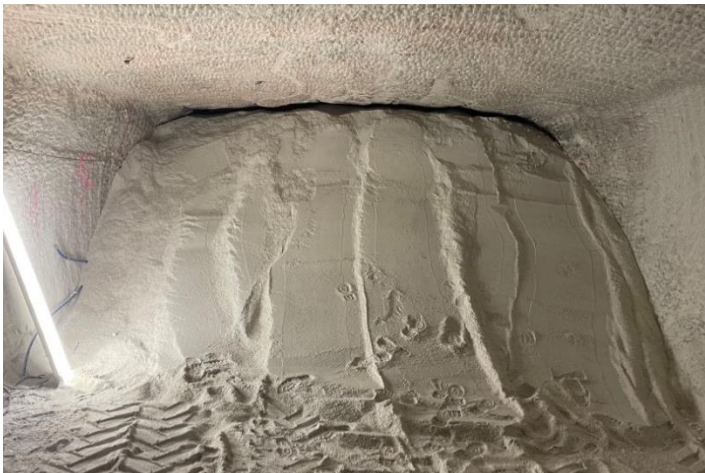
Abbildung 66: Firstbündige Verfüllung mit KOMPASS-Material (Foto Autor)
