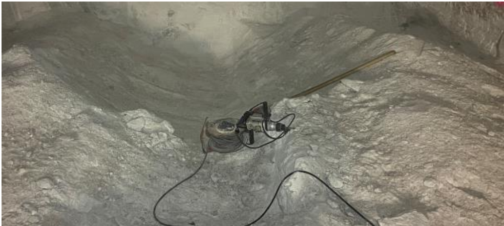
Abbildung 10: Feinarbeiten an der Grabenkontur um Radien anzugleichen (Foto Autor)
