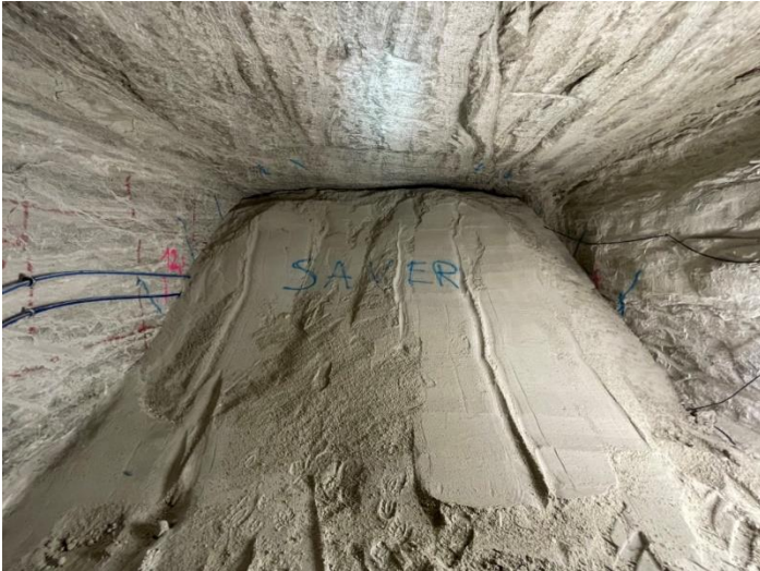
Abbildung 64: Firstbündige Verfüllung mit GESAV-Material (Foto Autor)
