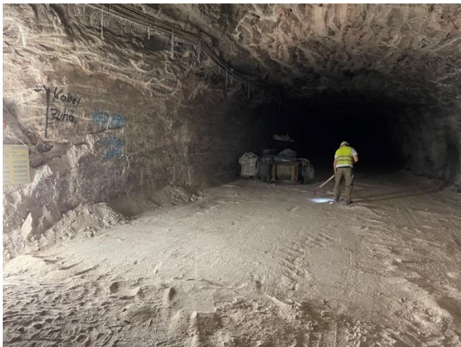
Abbildung 48: Herstellung des Mischplatzes für die Mischung der Salzbinderkomponenten (Foto Autor)
