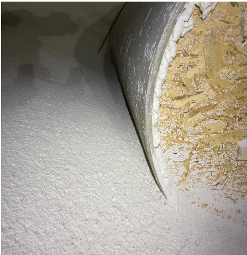
Abbildung 42: Verfüllung Ringraum um POLLUX-Dummy (Foto Autor)
