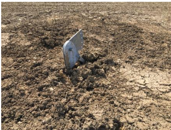
Abbildung 13: Abspannfundament nach dem Eingraben und Auflasten. [ZSW]
