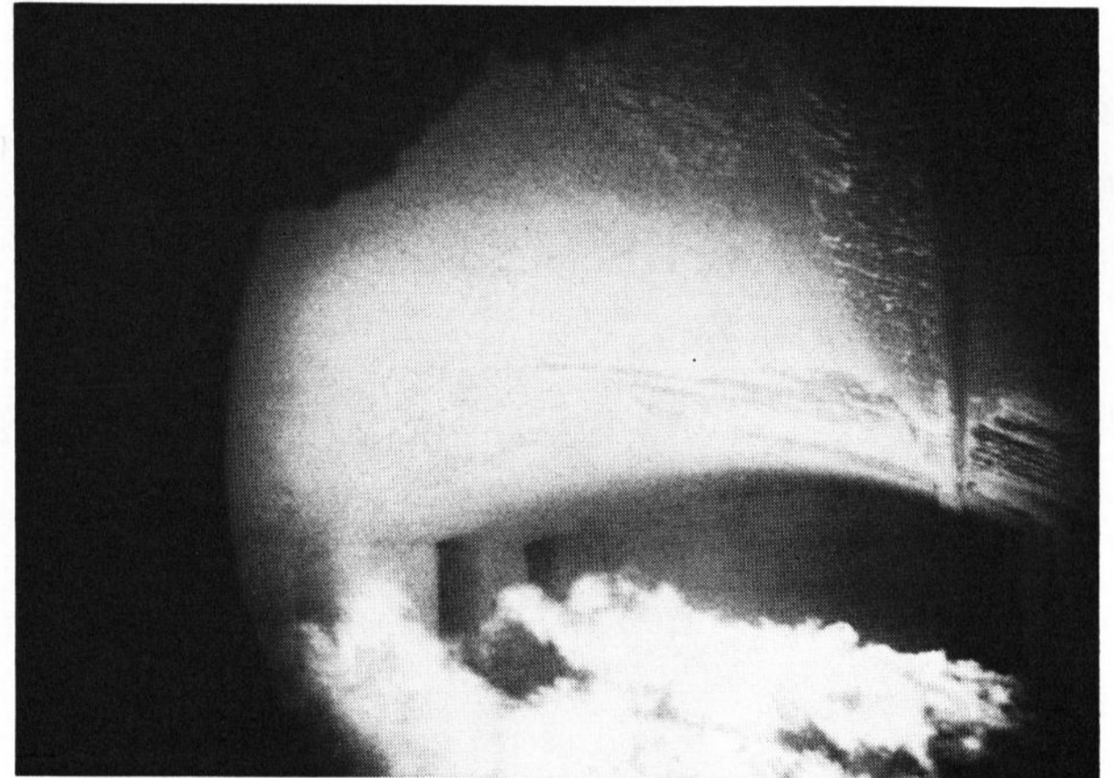
Bild 6. Blick in eine Querbrennerwanne, Flamme und Gewölbe ( 1/500\text{ s} ).
