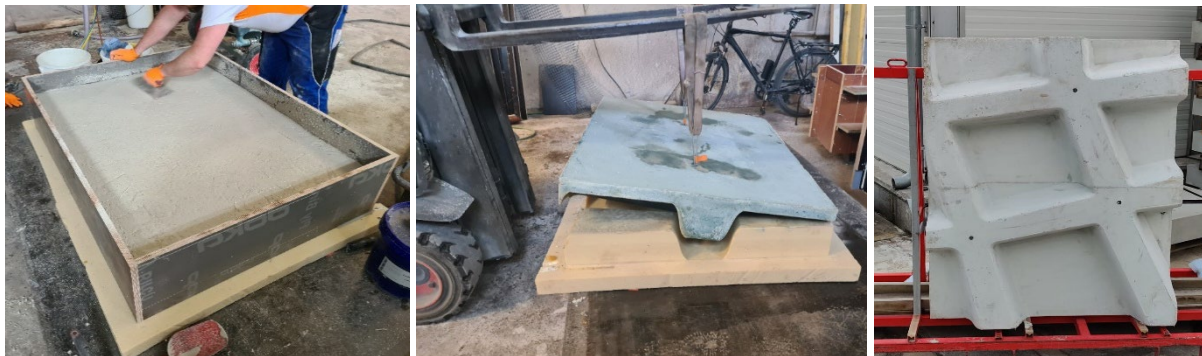
Abb. 13; links: Gegossener Geopolymerbeton, mitte: Ausschalprozess, rechts: ausgeschaltes Rippendeckenelement
