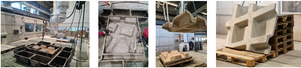
Abb. 14; 1. von links: robotisches SC3DP [6], 2. von links: zusätzliche Glasfaserbewehrungsschicht, 3. von links: Ausschalprozess, 4. von links: fertiges dünnwandiges Rippendeckenelement
