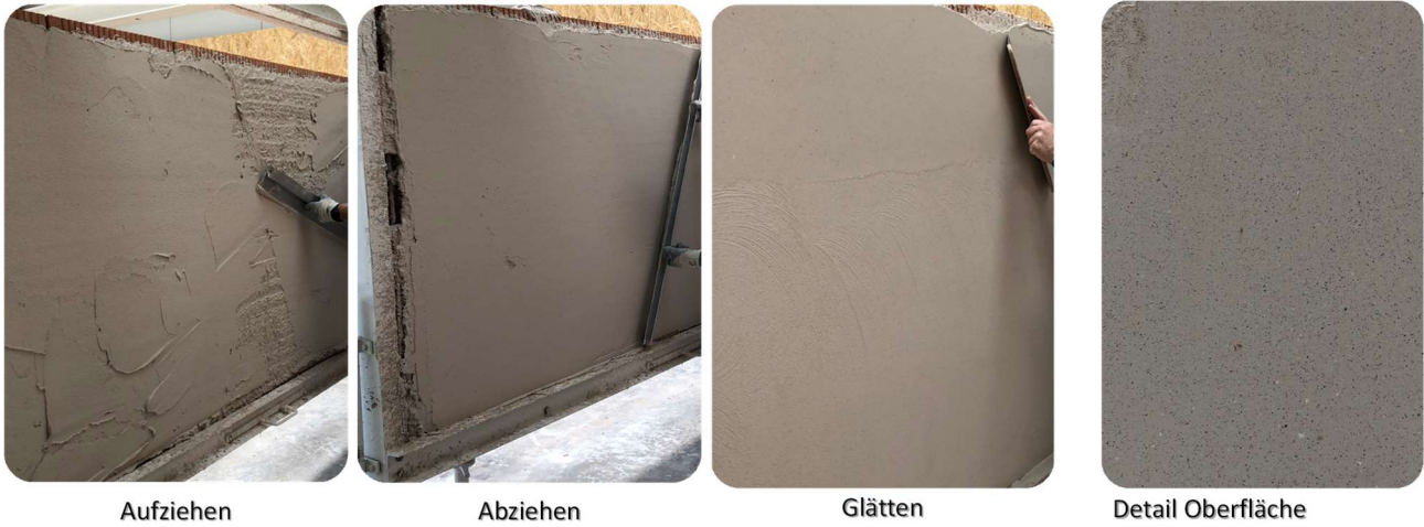
Abb. 21: Putzversuche an Testflächen. Hier am Beispiel einer Putzgipsmischung mit 32 % RC-SG ind. mit optimalem Gehalt einer vorzugsweise zu verwendenden Methylcellulose
