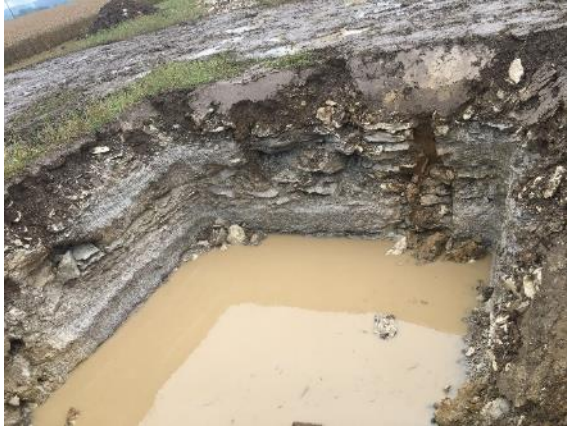
Abbildung 11: Vorbereitung der Gruben für die sechs Abspannfundamente eines WMM [ZSW]
