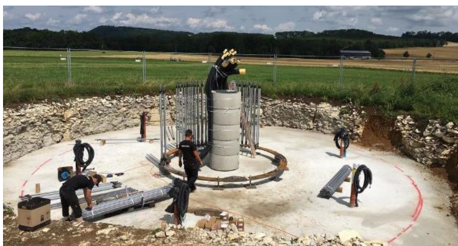
Abbildung 30: Bau der Ankerkörbe mit unterem Stahlring und den Ankerbolzen. Zu sehen sind die durch die Sauberkeitsschicht geführten KG/Hüll-Rohre und das flexible Rohr der Sohldruckgeber [ZSW]
