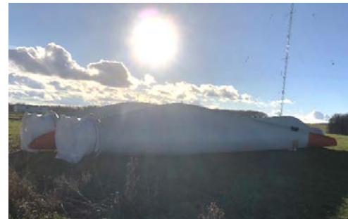
Abbildung 99: Die Rotorblätter wurden gegen äußere Windeinflüsse gesichert und versetzt zueinander gelagert. [ZSW]
