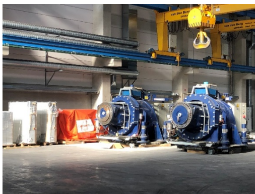
Abbildung 56: Ausgewählte Maschinenträger zum Ausbau der Getriebe. [ZSW]
