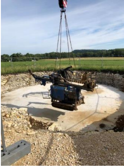
Abbildung 24: Einheben des Bohrgeräts in die Fundamentgrube auf die Sauberkeitsschicht mithilfe eines Mobilkrans [ZSW]
