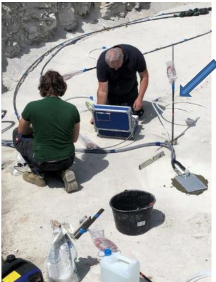
Abbildung 26: Die Extensometerstangen (blauer Pfeil) wurden in die Bohrlöcher eingebracht und die Anker einzementiert [ZSW]
