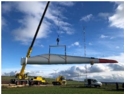
Abbildung 98: Abladen der Rotorblätter an dem dafür vorgesehen Standort. Zu sehen ist die mit Folie eingeschweißte Blattwurzel (links). [ZSW]
