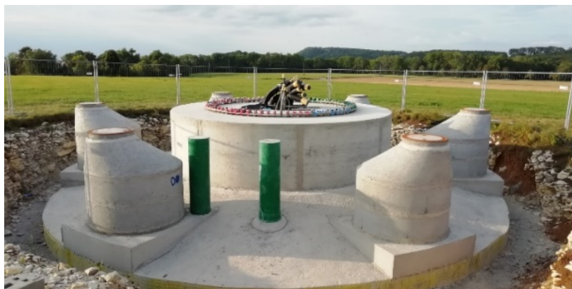
Abbildung 33: Fertiges, noch nicht verfülltes Fundament einer FWEA mit den im Umfang verteilten sechs Zugangsschächten zur geotechnischen Instrumentierung [ZSW]
