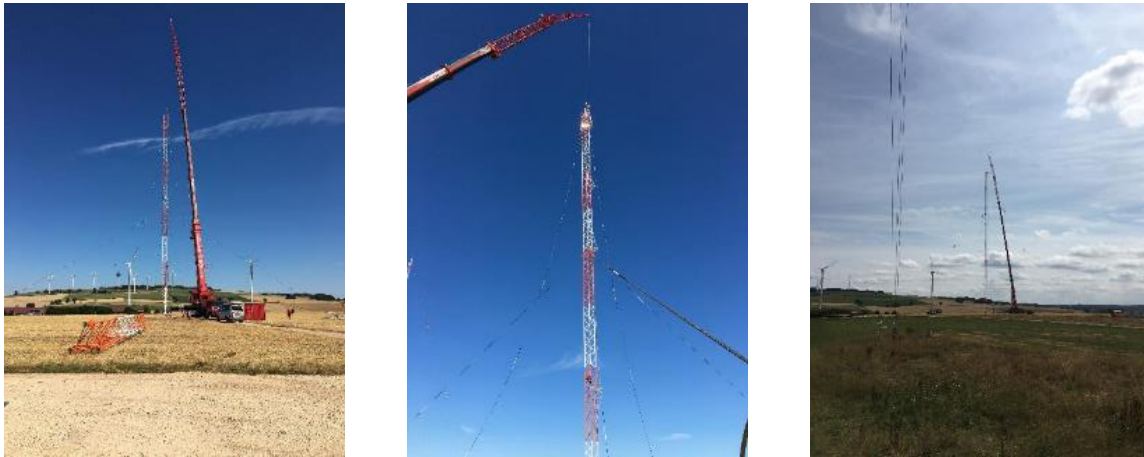
Abbildung 15: Errichtung des südöstlichen Windmessmasts nach der Ernte 2022. [ZSW]
