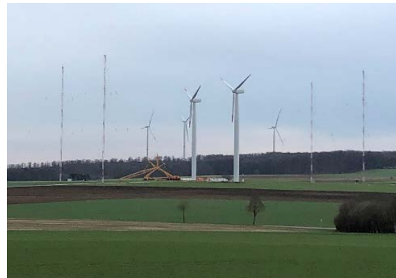
Abbildung 115: Das hardwareseitig fertige Testfeld mit den vier meteorologischen Masten und den beiden Forschungsanlagen. [ZSW]
