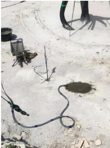
Abbildung 28: Zum Schutz wurde über den Sohldruckgeber eine Mörtelschicht aufgebracht und die Sensorleitungen zu einem späteren Zeitpunkt durch ein flexibles Rohr geschützt. [ZSW]
