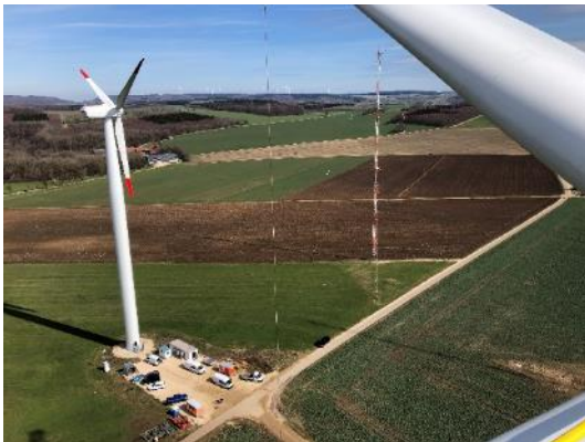
Abbildung 114: Die Errichtung der zweiten Anlage erfolgte analog an den Folgetagen. [ZSW]
