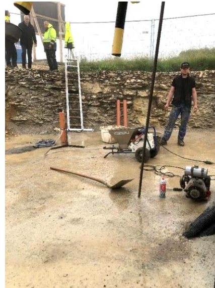
Abbildung 29: Die Bohrlöcher wurden mithilfe eines Füllbinders/Dämmers verschlossen und auch ein Schutzrohr für das Extensometer im selben Arbeitsschritt eingebracht (3. Punkt der Ausführungsplanung) [ZSW]
