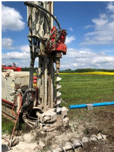
Abbildung 20: Die Bohrung eines Loches zur Sensorapplizierung im felsigen Untergrund in eine Tiefe von 5 m [ZSW]
