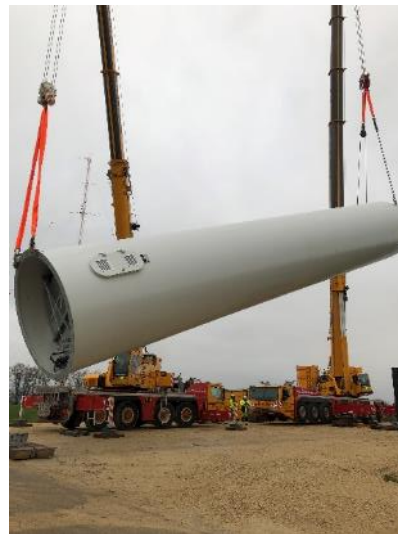
Abbildung 103: Für die Errichtung ist ein Haupt- und ein Hilfskran zum Wenden des Segments notwendig. [ZSW]
