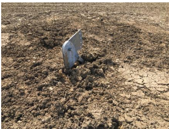
Abbildung 13: Abspannfundament nach dem Eingraben und Auflasten. [ZSW]
