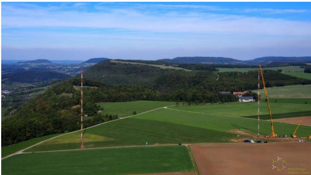
Abbildung 10: Aufbau des zweiten Windmessmasts WMM-NO Mitte September 2018 [ZSW]
