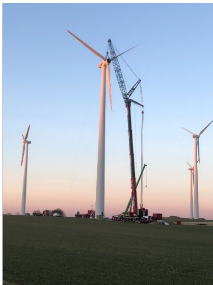
Abbildung 44: Abbau der ersten WEA vom Typ PWE650 [ZSW]
