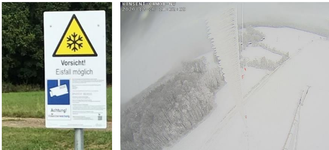
Abbildung 5: Montierte Warntafel am Wegrand der Ortsverbindungsstraße Kuchalb-Oberweckerstell (links) und Eisfahnen an einem Abspannseil des Windmessmast Nordwest (rechts) [ZSW].
