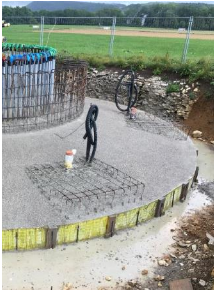
Abbildung 31: Das Hüllrohr (Punkt 5 und 7 der Ausführungsplanung) der Extensometerstangen sowie das flexible Schutzrohr der Sohldruckgeber ragen aus dem betonierten Fundament heraus [ZSW].
