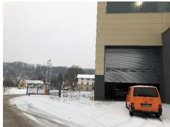
Abbildung 37: Zufahrtstor mit ausreichender Breite und Höhe für Schwerlasttransporte [ZSW]
