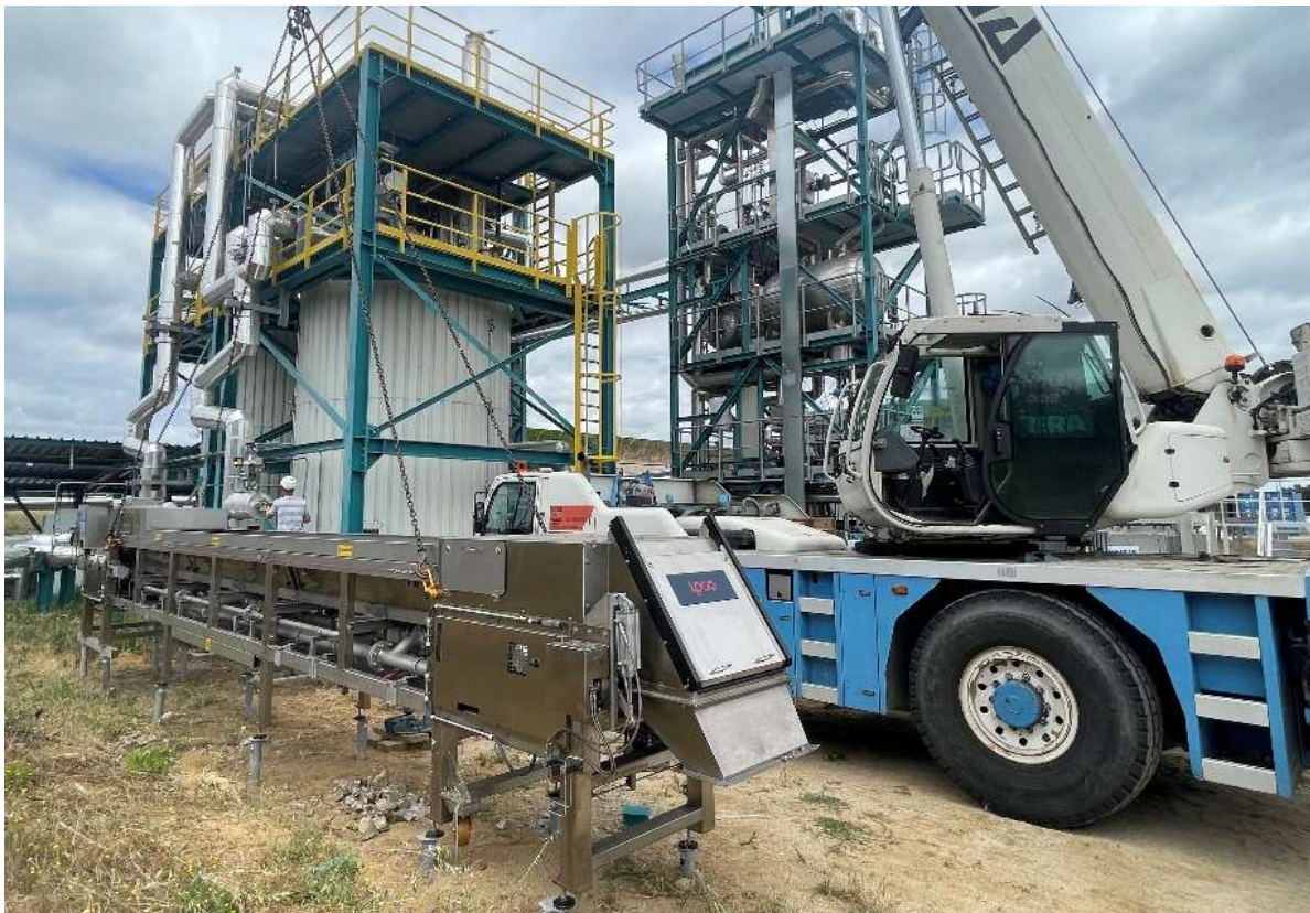
Abbildung 2 Leihkühlband der Fa. IPCO auf der EMSP während der Installation
