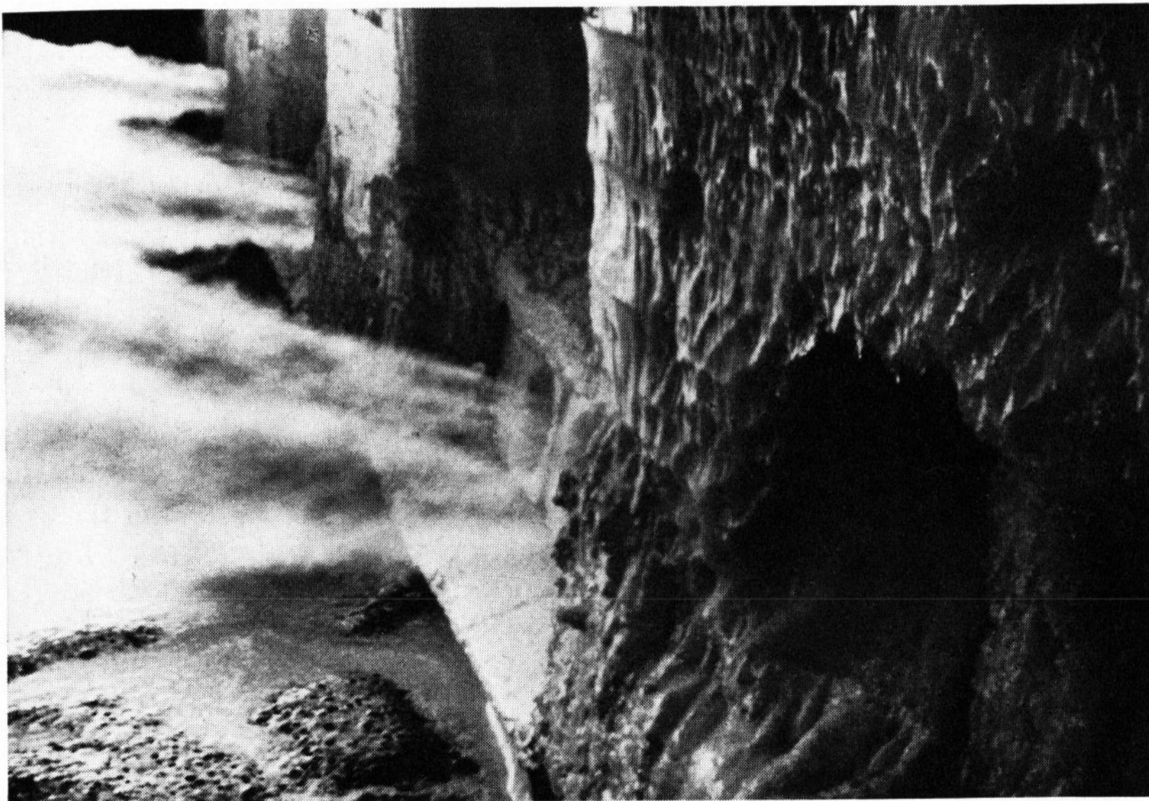
Bild 2. Seitenwand einer Querbrennerwanne, Flammenwurzel und Brennerbank ( \frac{1}{125} s).
