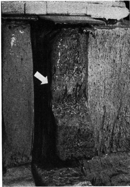
Bild 8. Wannenblock mit braunen Kratern.
