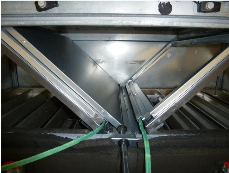
Abbildung 2-33 - Zusätzliche Pendelklappe und Heizelemente an den Umschaltklappen.
