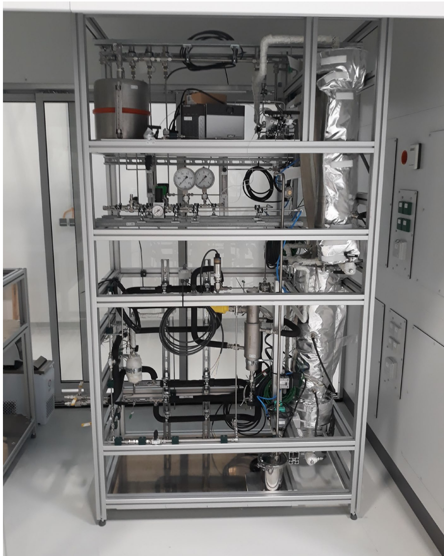
Abbildung 50. Aufstellung der vormontierten Gestelle im Abzug des LIKAT.
