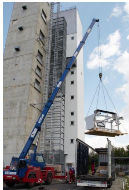
III- 14: Einhub des Receivers
