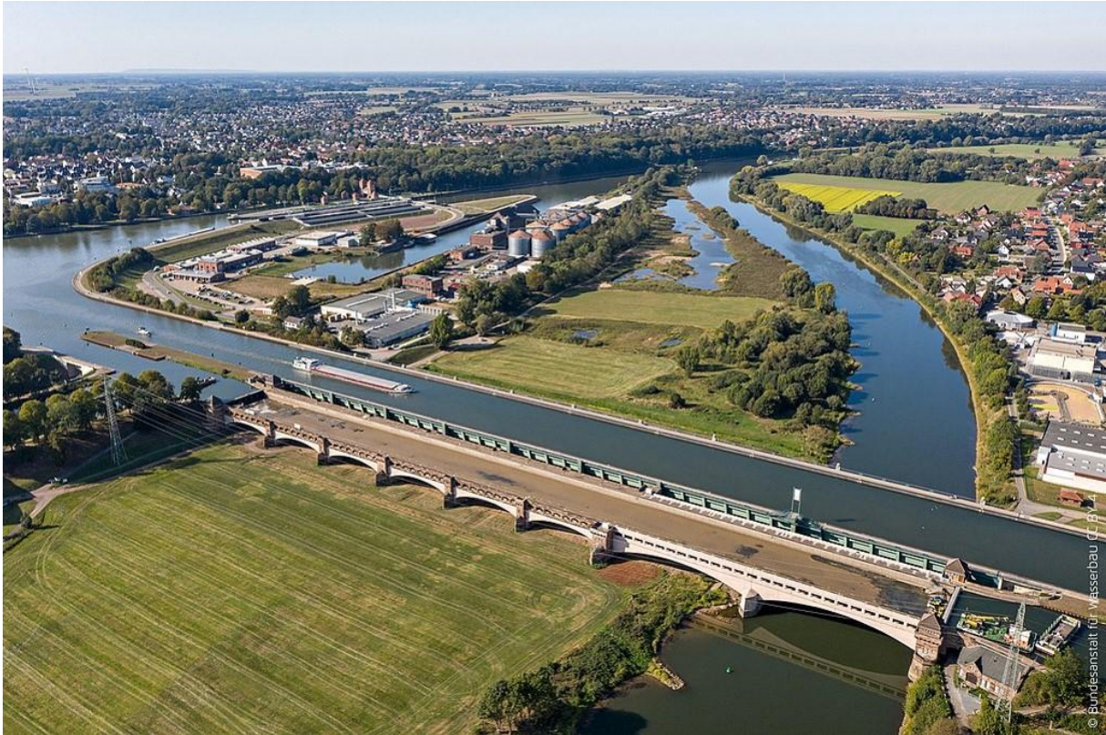
Abbildung 1: Luftaufnahme des Untersuchungsobjekts Alte Brücke des Mittellandkanals über die Weser. [BAW, 2020]
