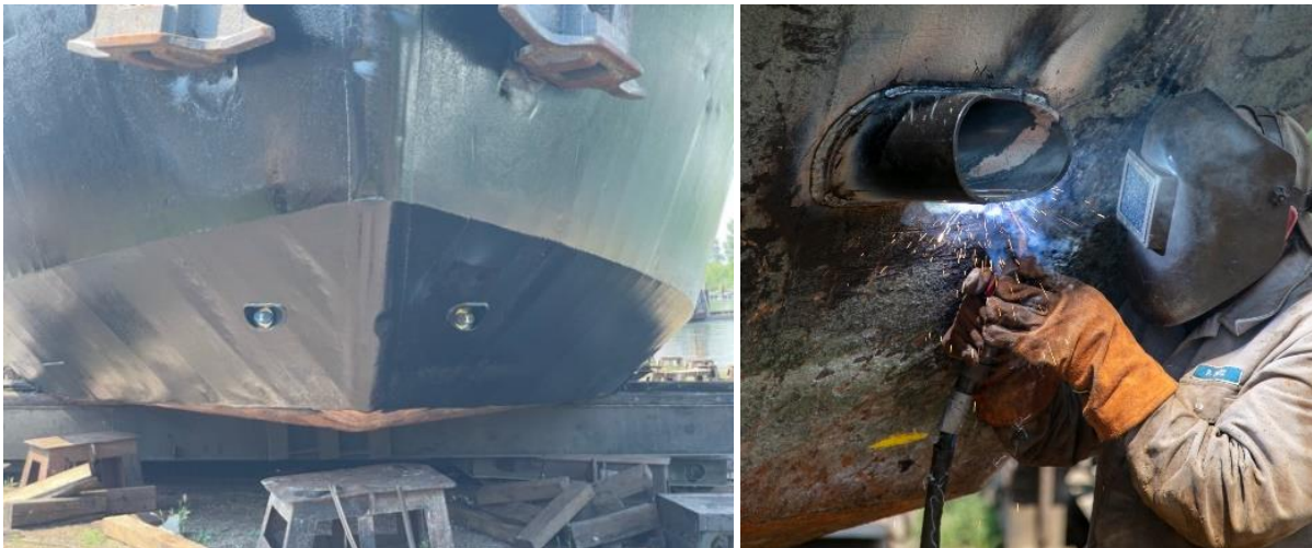
Abbildung 23 Installation der ADCP-Strömungssensoren (Aqua Doppler Current Profiler)
