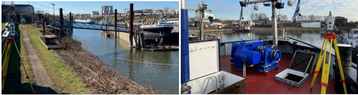
Abbildung 20 Extrinsische Sensorkalibrierung mit der RWTH-Totalstation
