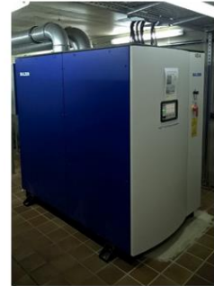
4 neue Verdichter (3 Baugrößen) magnetgelagert, FU-Betrieb, Schraubenverdichter
