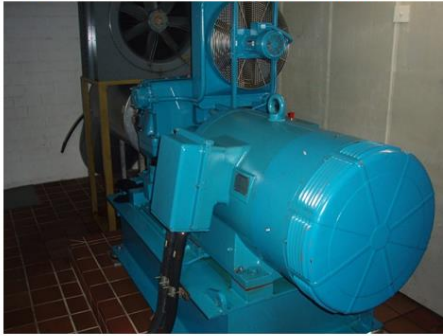
4 HV Turboverdichtern (Bj. 1993)
