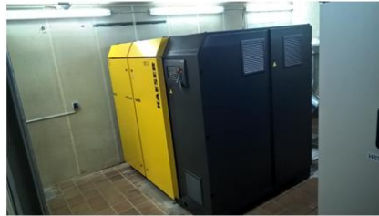
4 neue Verdichter (3 Baugrößen) magnetgelagert, FU-Betrieb, Schraubenverdichter
