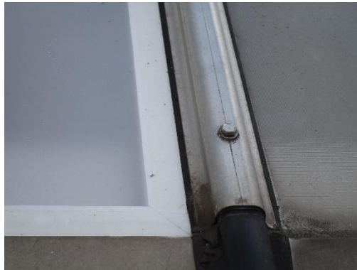
Passfähigkeit des Moduls (links) in die bestehende Konstruktion
