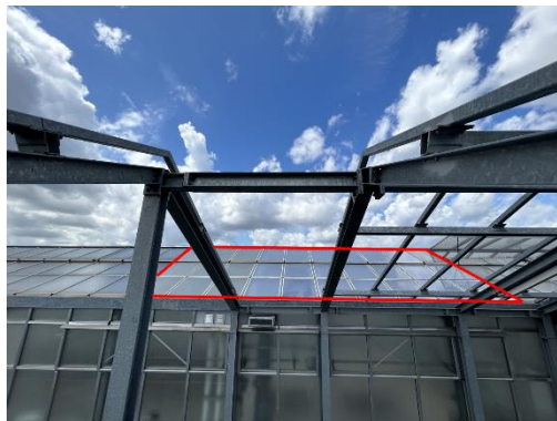
Mit Light-Light-Roof-Modulen fertiggestellte Dachfläche (rote Umrahmung)
