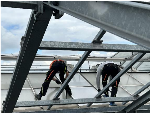
Montage der Light-Light-Roof-Module
