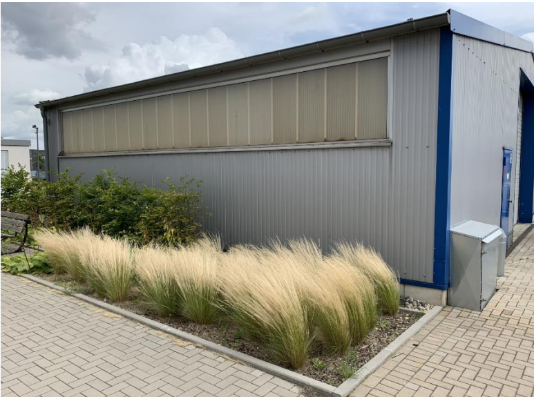
Bild 15: Leichtbauhalle am Standort des Fraunhofer UMSICHT in Oberhausen, mit Polycarbonat-Doppelstegplatten.
