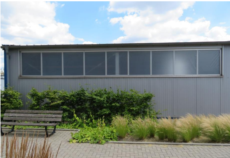
Bild 19: Aus Light-Light-Roof-Modulen bestehender Lichtausschnitt der Leichtbauhalle am Standort des Fraunhofer UMSICHT in Oberhausen nach Ende der Montagearbeiten.
