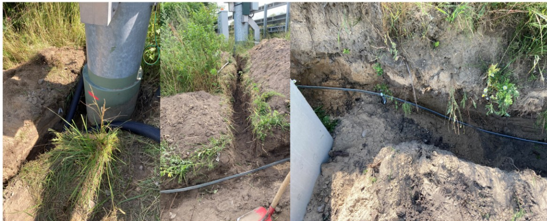
Abbildung 7 Tiefbau, Ringerder, Leerrohr (30.06.2023)
