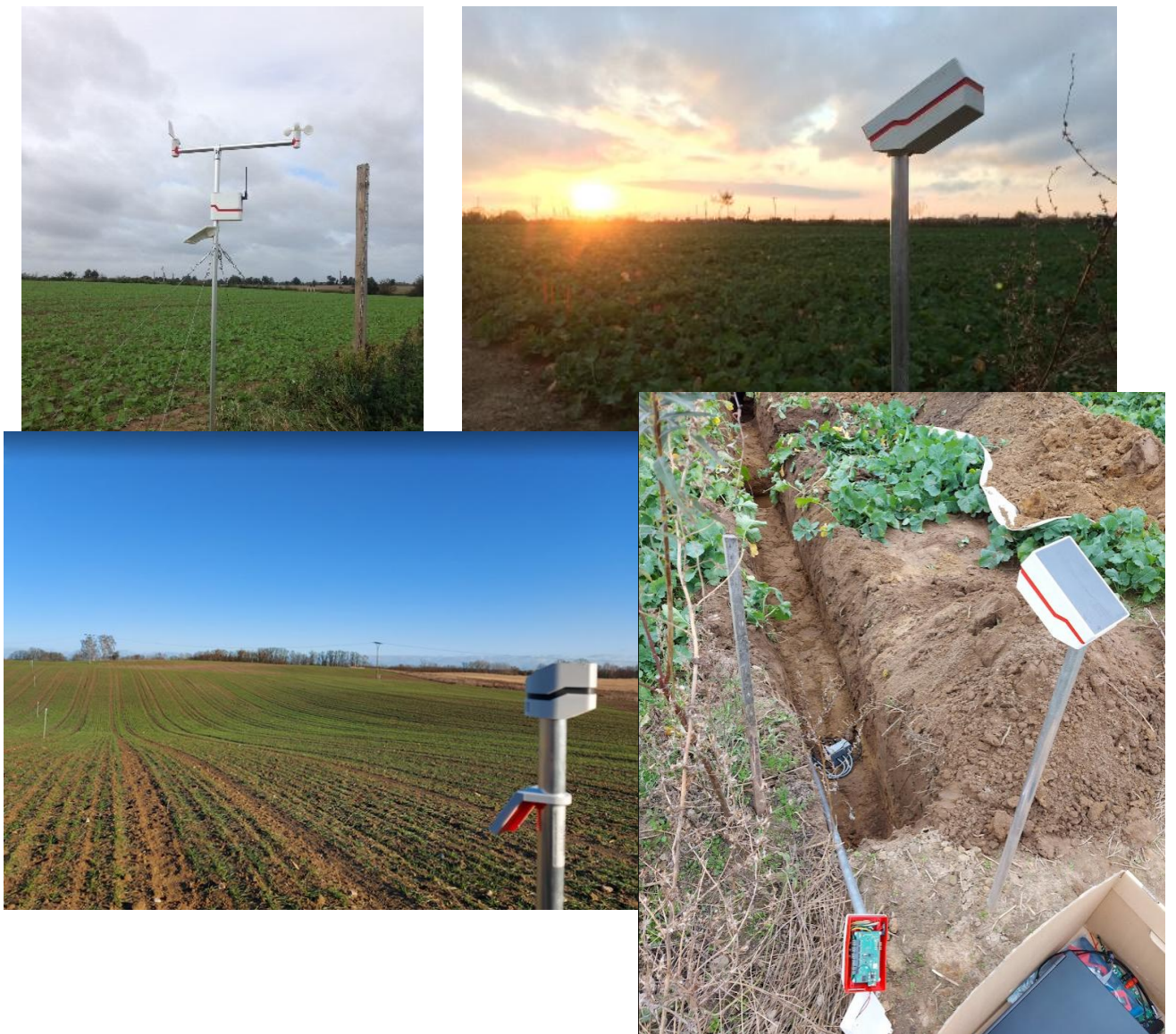
Abbildung 14: (a) Gateway-Knoten in Großmutz (b) Bodensensor-Knoten in Großmutz (c) BSNs in Dahmsdorf (d) Installation eines Bodensensor-Knotens mit unterirdischen Bodensensoren vom Typ 10HS
