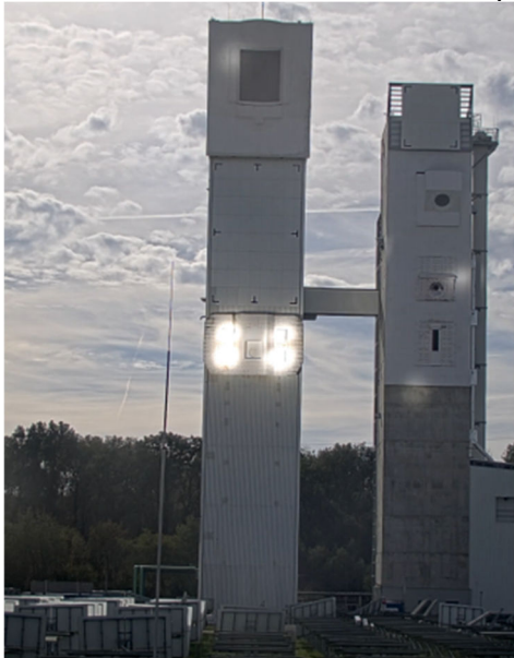
Abbildung 71: Test der STRAL-HeliOS-Schnittstelle am Solarturm in Jülich.
