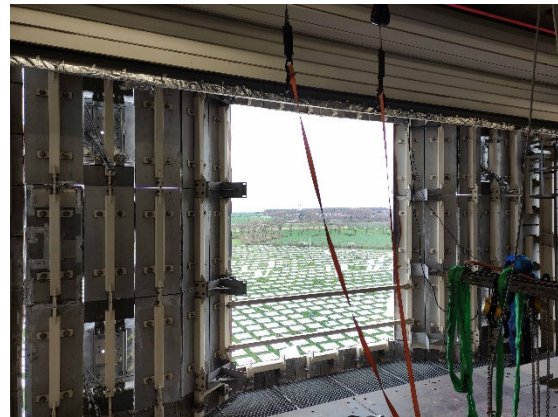
b) Nach Installation aller Attrappen
