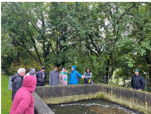
Abbildung 33 Zulaufverteilerbauwerk CW Lobeta
