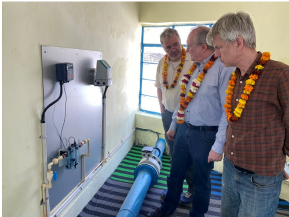
Abbildung 39 Wasseraufbereitungsanlage Haridwar Uferfiltrations-Demonstrationsbrunnen 18
