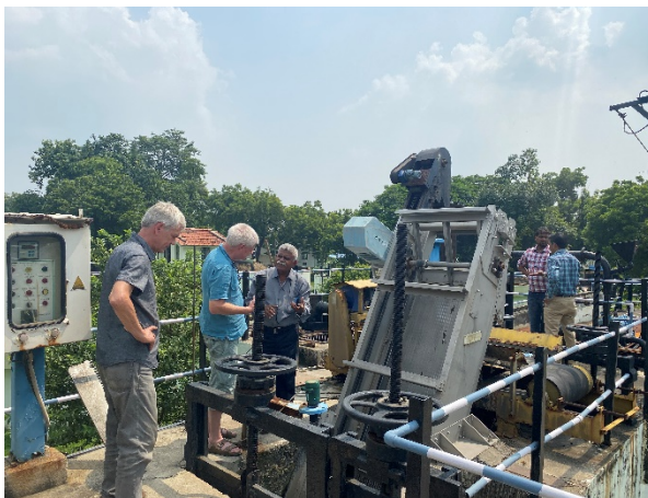
Abbildung 16 Erste Behandlungsstufe - Rechen
