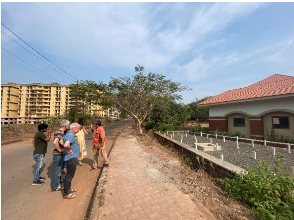
Abbildung 27 CW für Oberflächenwasserbehandlung auf dem Campus der BITS
