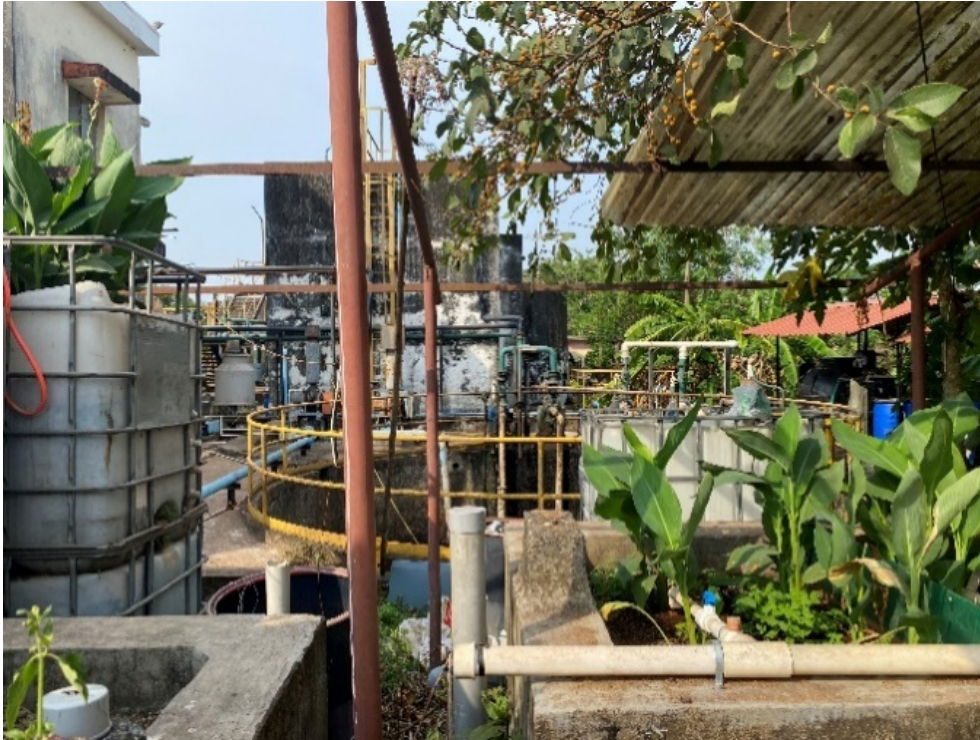
Abbildung 28 Versuchs- und Lehr-Kläranlage auf dem Campus der BITS
