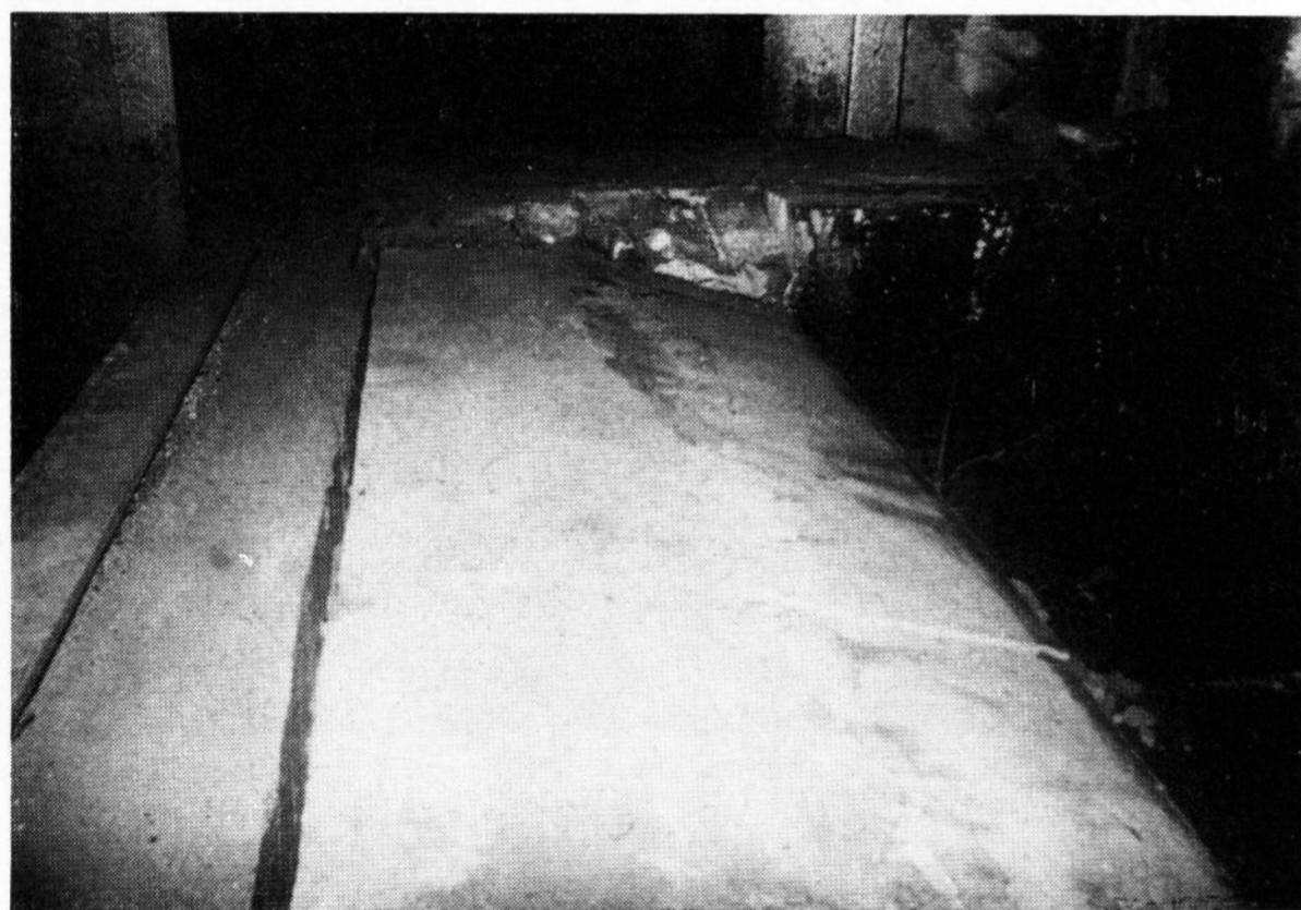
Bild 13. Steine in der Stirnwand eines Einlegevorbaus nach 12 Monaten.
