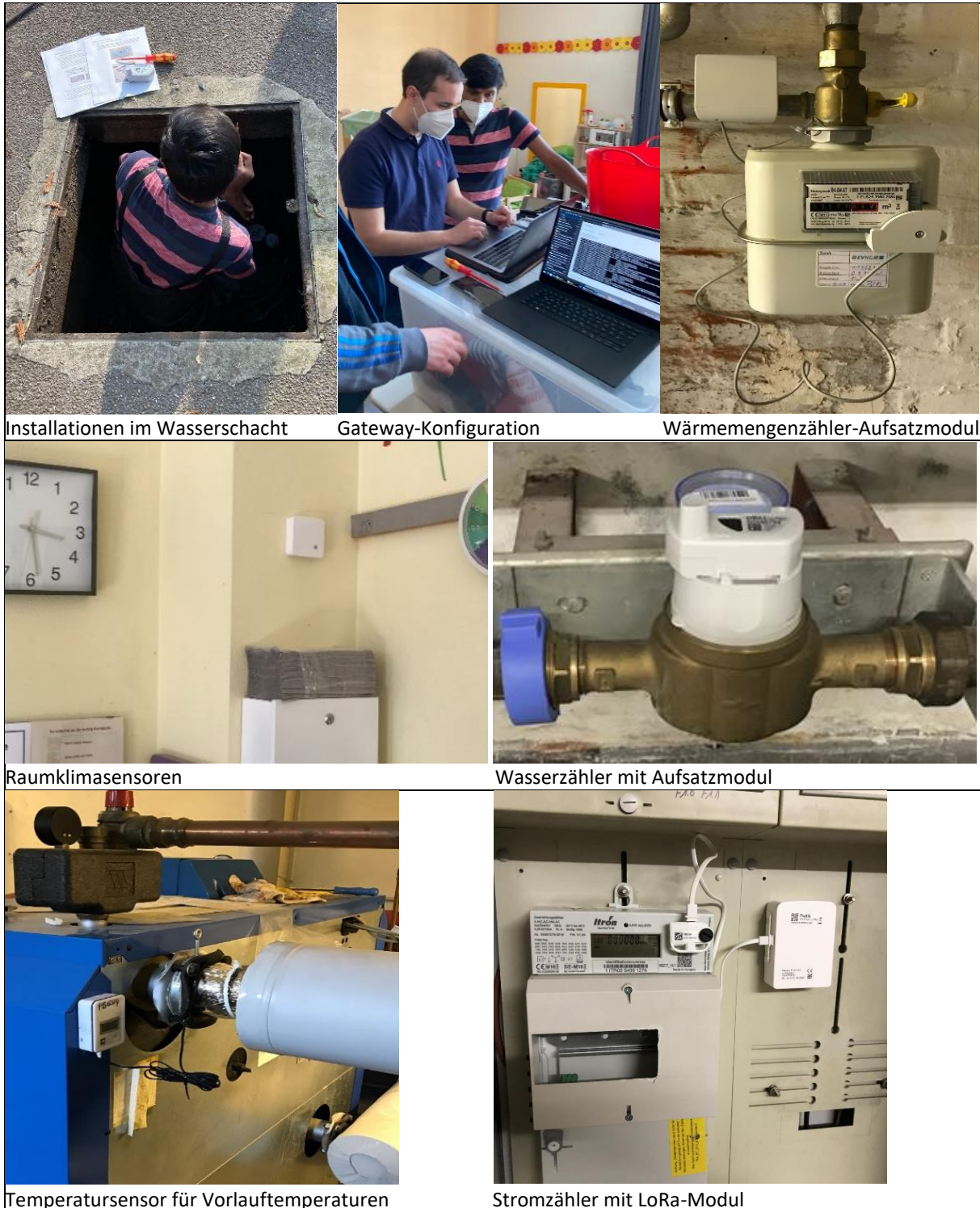
Abbildung 11: Eindrücke von der Installation von Zählern und Sensorik sowie der Implementierung der Datenübertragung
