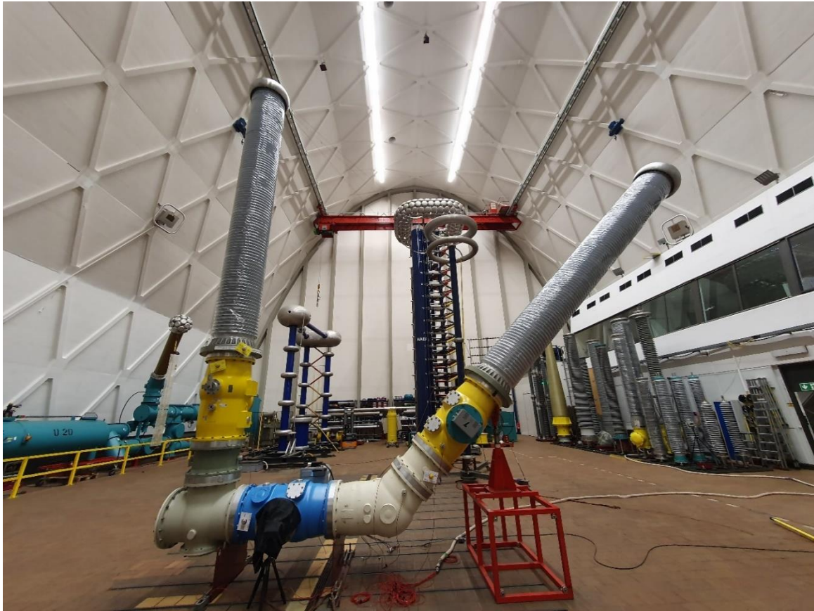
Abbildung 16: Prüfaufbau zur Ermittlung der dielektrischen Festigkeit von Clean Air beim Einsatz in Trennschaltern
