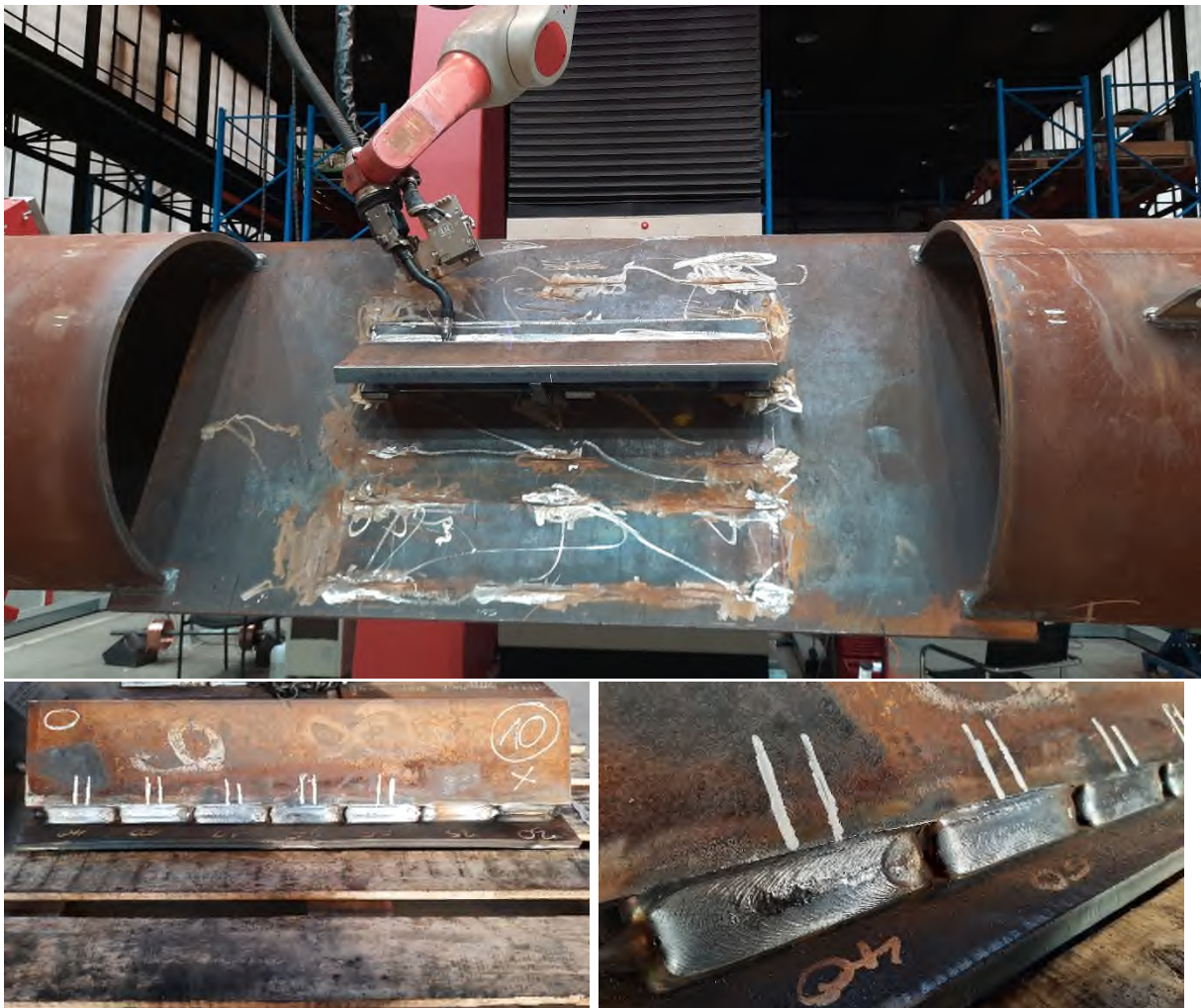
Bild 11: Schweißversuche an ebenen Ersatzgeometrien zur Bestimmung des nutzbaren Schweißparameterfeldes und der korrespondierenden Schweißprozessstabilität und Schweißnahtqualität
