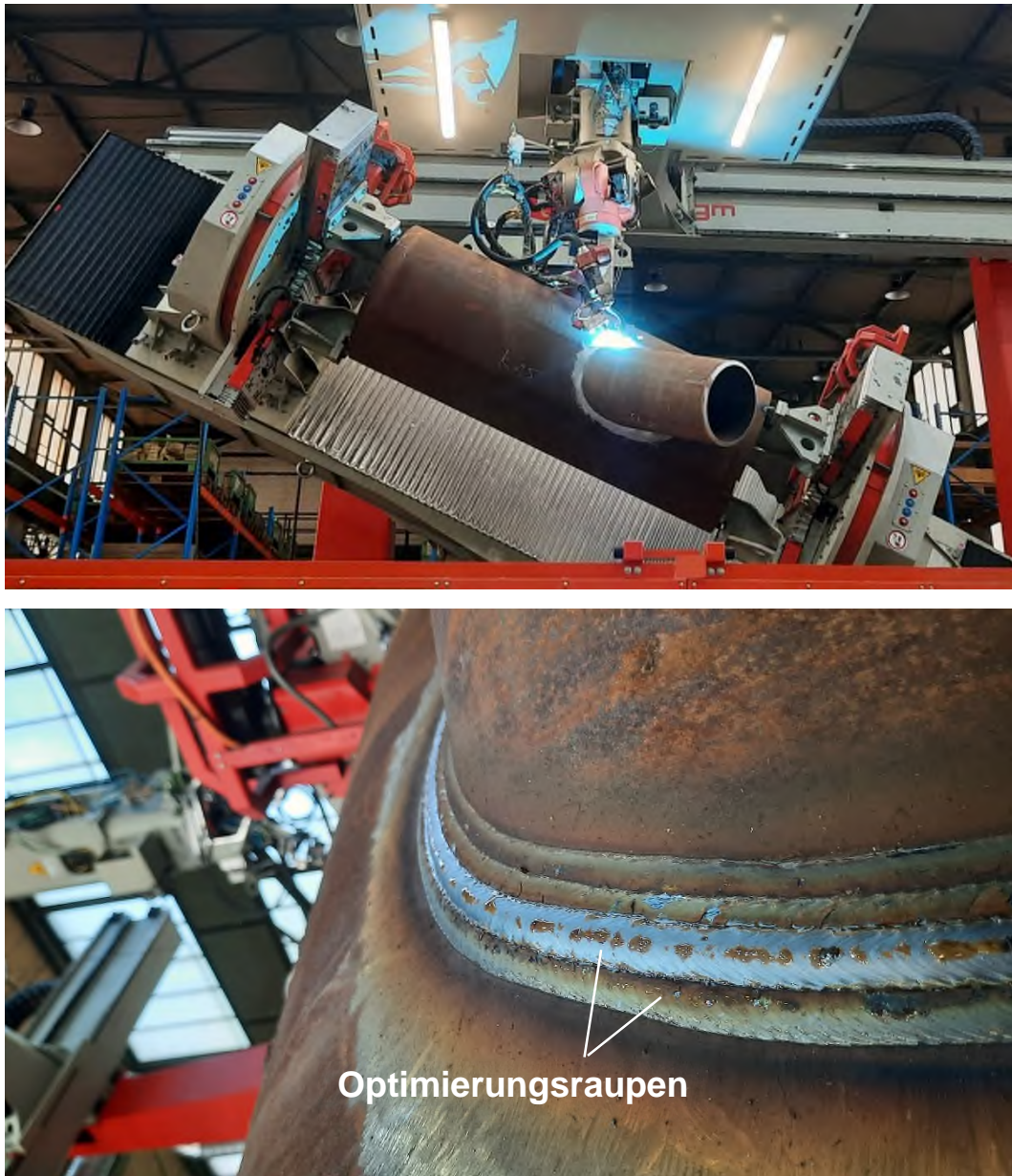
Bild 26: Fertigung eines Knotens im Maßstab 1:1.5 sowie die resultierende Schweißnahtgeometrie
