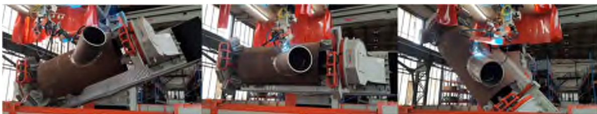
Bild 13: Bewegung des Knotens durch den Manipulator während des Schweißens von Rohrknotten im Maßstab 1:1
