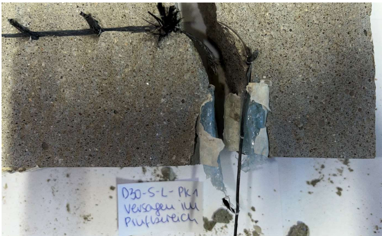
Abbildung 53: D30-S-L-PK1 aufgesägt nach Versuchsdurchführung; Bild 2/2; Foto: TUD IMB
