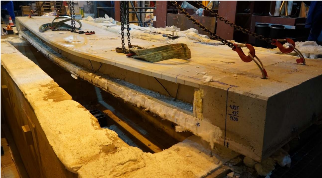
Abbildung 22: Ansicht des Probekörpers ohne seitlicher Wärmedämmung nach der Brandprüfung (Blick aus Richtung Nord-West)
