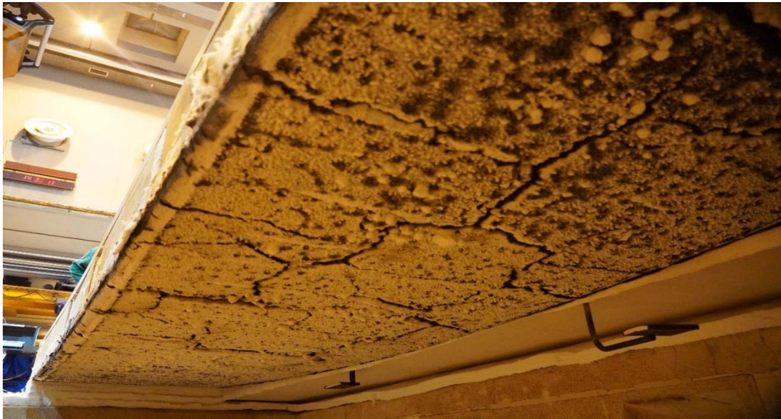
Abbildung 24: Ansicht der beflamten Seite des Probekörpers nach der Brandprüfung (Blick aus Richtung Nord-West)
