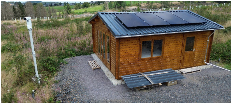
Abbildung 2: Technikraum und Demonstrator auf der Versuchsfläche in Cursdorf
