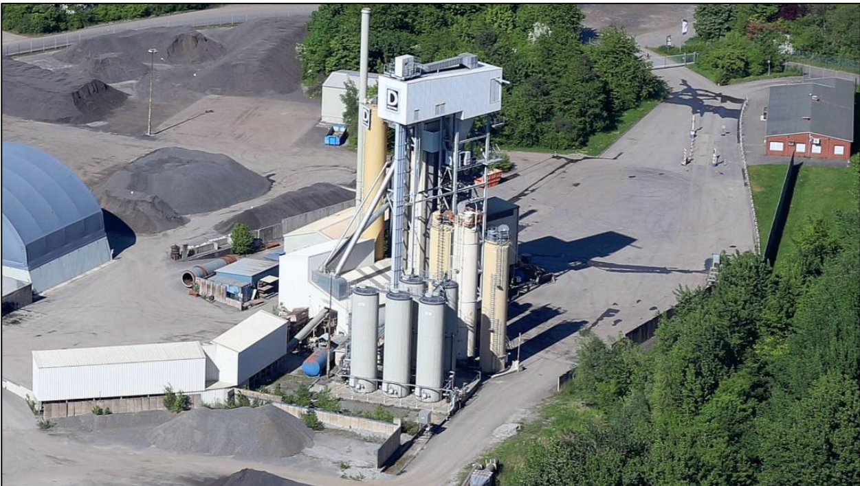
Bild 3-1: Asphaltmischanlage der DEUTAG Nord, Zweigniederlassung der BAG, in Groß Bülden
