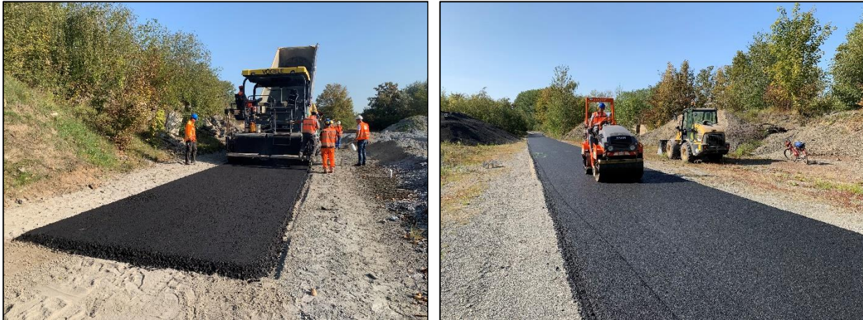
Bild 5-1: Einbau der Praxisvarianten
