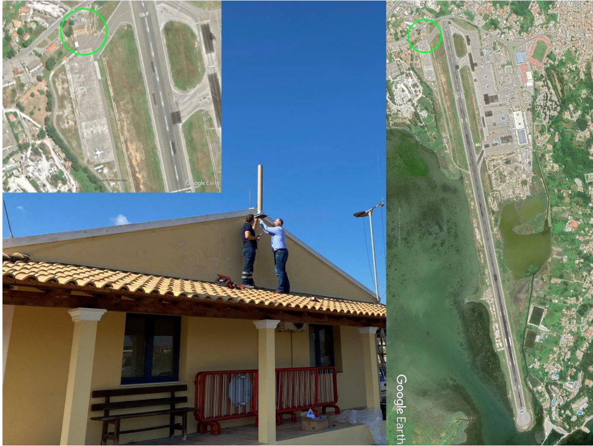
Abbildung 2.1: Flughafen Kerkira und Standort der GLASS-Installation. Die VDB-Antenne von Kathrein ist auf dem Dachfirst des gelben Gebäudes im Nordwesten des Flughafens zu
