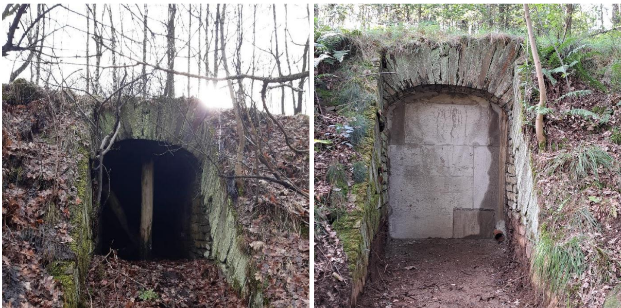
Abbildung 10: Natursteingewölbe vor der Sicherungsmaßnahme (links) und nach der Sicherung durch die Verfüllung mit Beton (rechts); Quelle: G.E.O.S.
