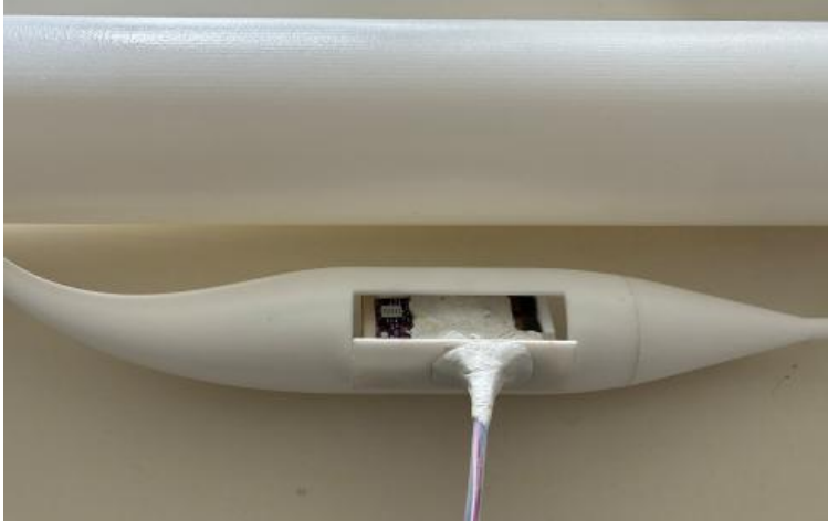
Abbildung 65: Einbau Sensorik in Bypass.
