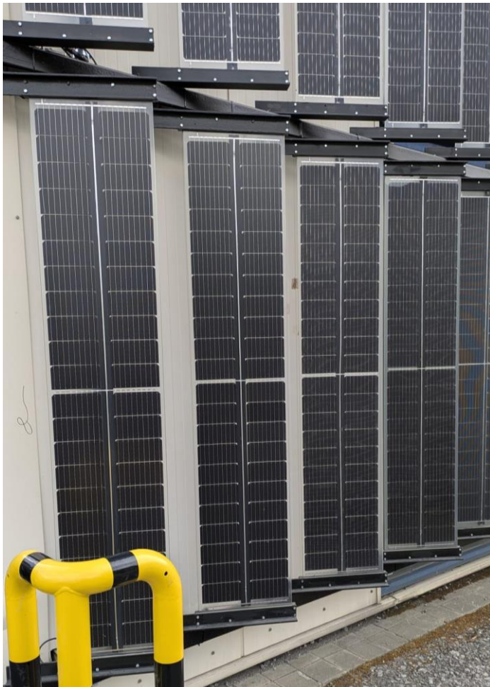
Abbildung 71 Im Rahmen des Projekts beim Projektpartner Flachglas Sachsen an der Fassade installierte PV-Module.
