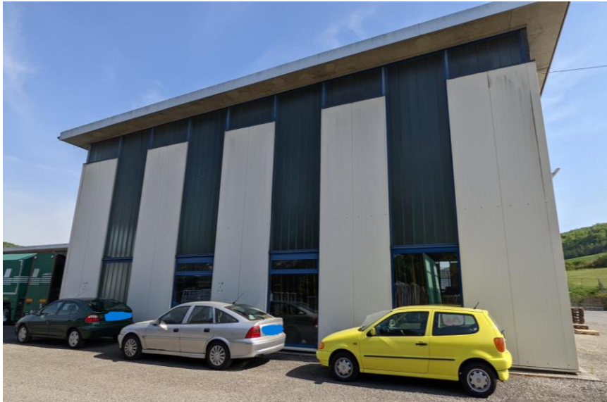
Abbildung 69 Foto der Fassade für die Pilotinstallation bei Flachglas Sachsen GmbH in Sülzfeld
