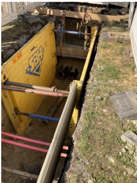
Abbildung 27: Errichtung der Verbindungsleitungen zwischen der Auskopplung industrieller Niedertemperaturabwärme und der Anbindung an die Technikzentrale im Shamrockpark Herne
