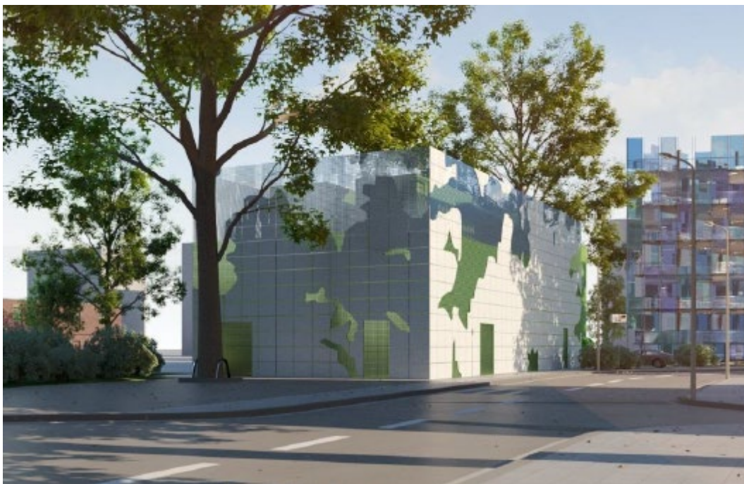
Abbildung 18: Außenansicht Technikzentrale Shamrockpark
