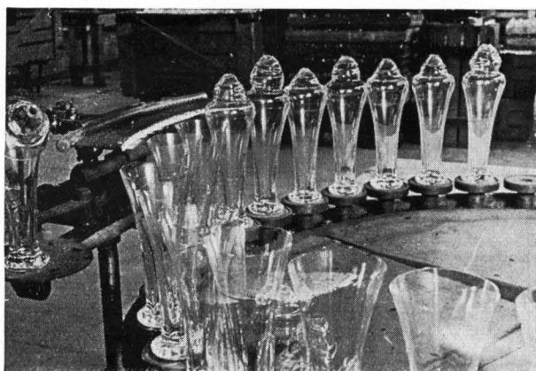
Bild 3. Absprengen der Oberteile von mundgeblasenen Trinkgläsern mit einem Reihenbrenner.
